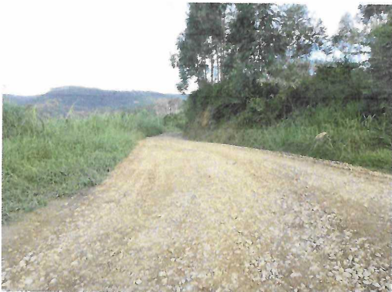
Imagem 25: Estrada na Localidade Rio Bandeira com material britado aplicado.
