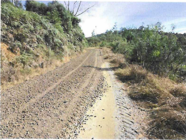
Imagem 30: Estrada na localidade Rio Bandeira com material britado aplicado.
