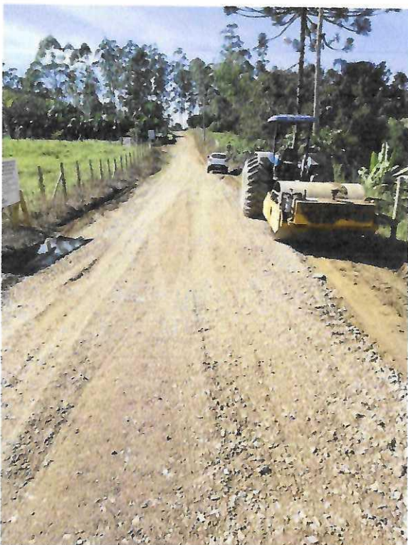
Imagem 21: Execução dos trabalhos de aplicação do material britado na Estrada da Localidade Rio Bandeira.
