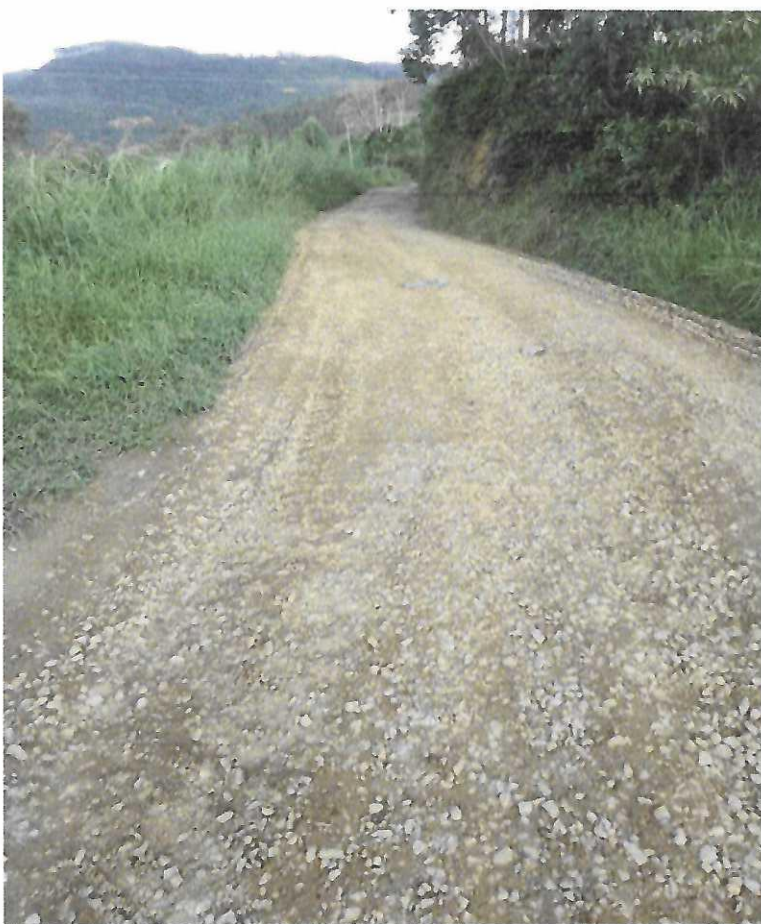
Imagem 24: Estrada na Localidade Rio Bandeira com material britado aplicado.
