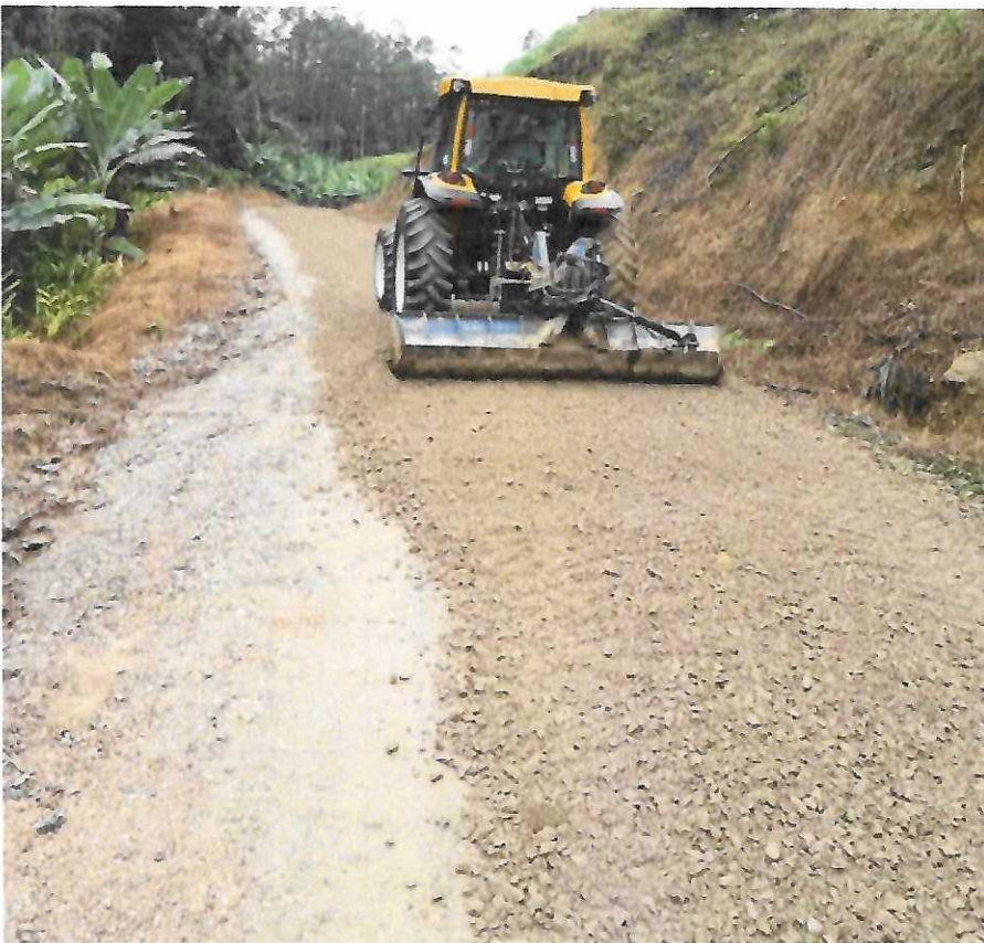
Imagem 13: Execução dos trabalhos de aplicação do material britado na estrada da Localidade Boa Esperança.
