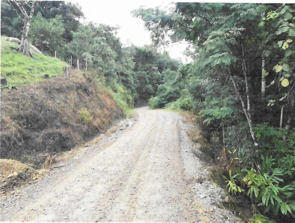
Imagem 16: Estrada na Localidade Boa Esperança com material britado aplicado.
