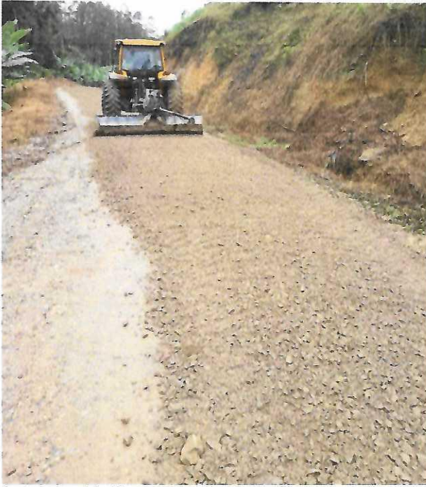
Imagem 14: Execução dos trabalhos de aplicação do material britado na estrada Localidade Boa Esperança.
