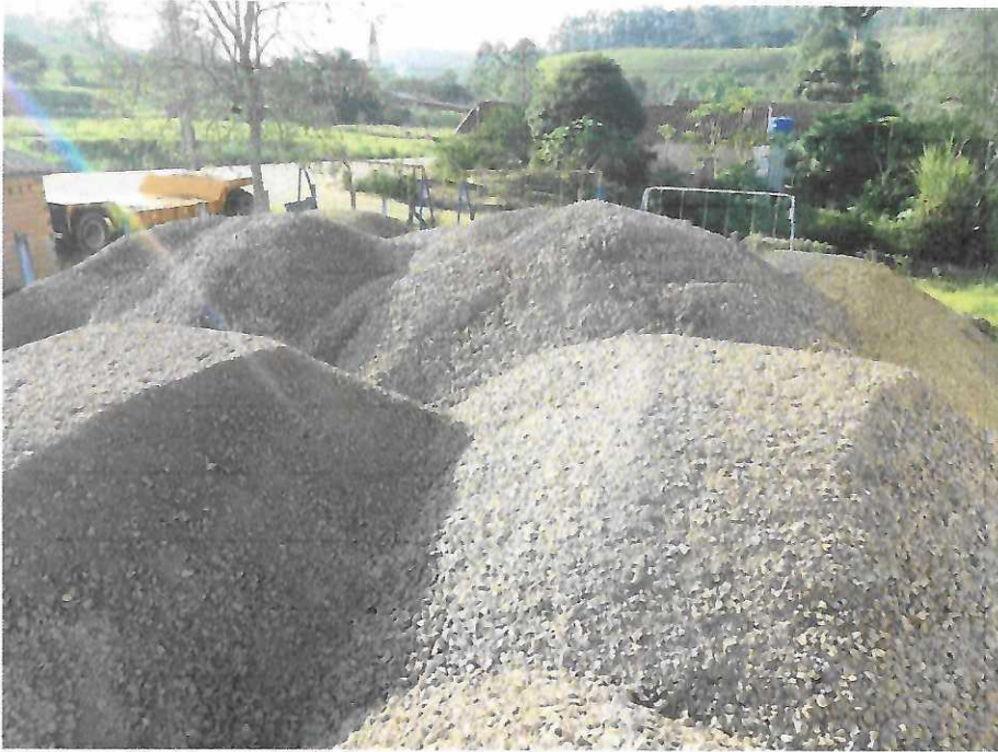
Imagem 06: Material britado recepcionado.
