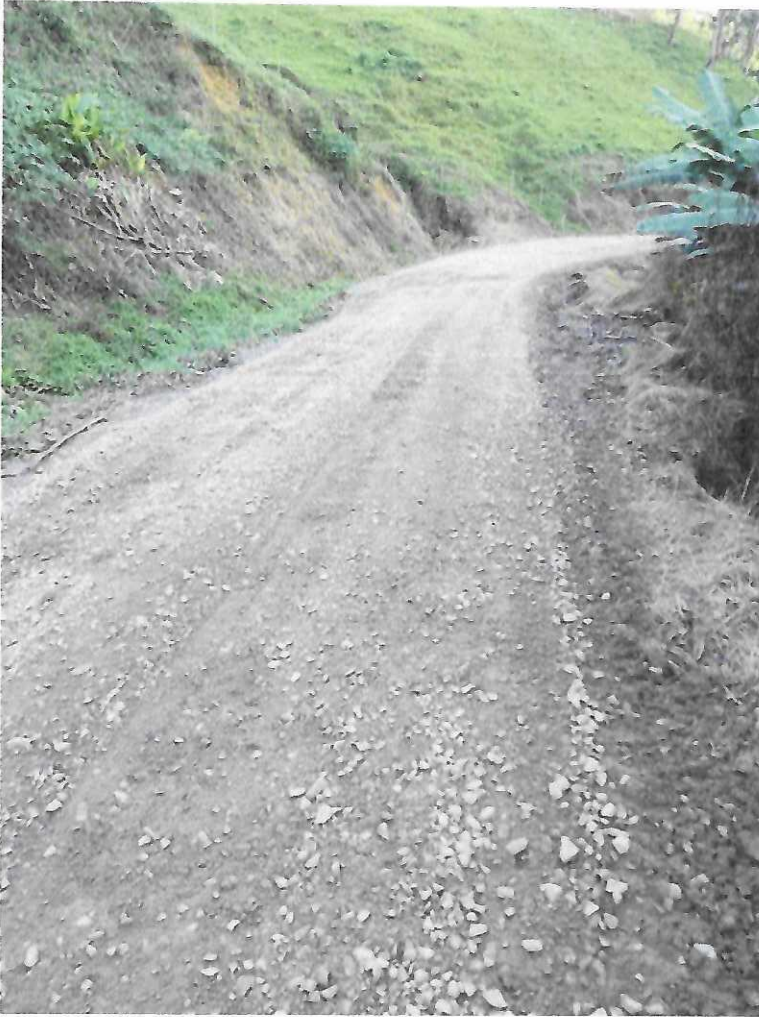
Imagem 28: Estrada na Localidade Rio Bandeira com material britado aplicado.
