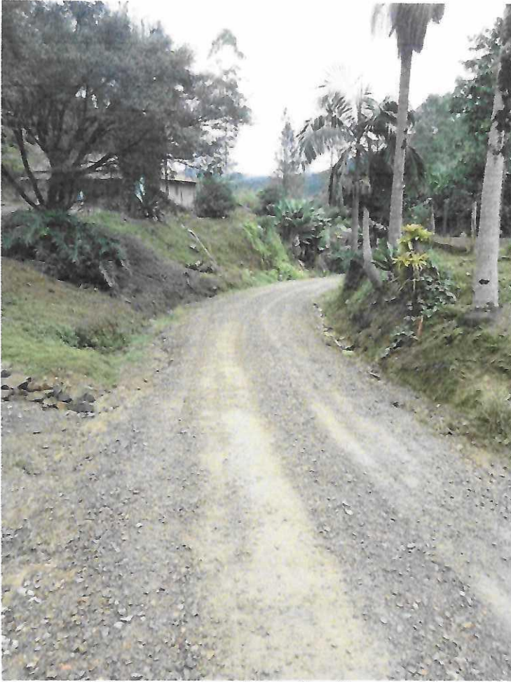
Imagem 18: Estradana Localidade Boa Esperança com material britado aplicado.
