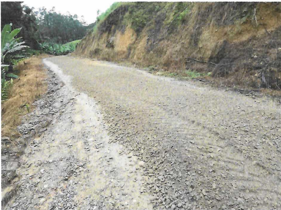
Imagem 15: Execução dos trabalhos de aplicação do material britado na estrada Localidade Boa Esperança.
