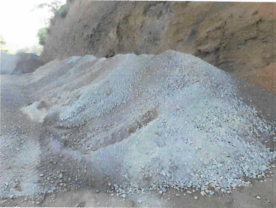
Imagem 01: Material britado recepcionado.
