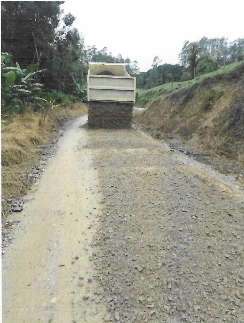
Imagem 11: Execução dos trabalhos de aplicação do material britado na estrada da Localidade Boa Esperança.
