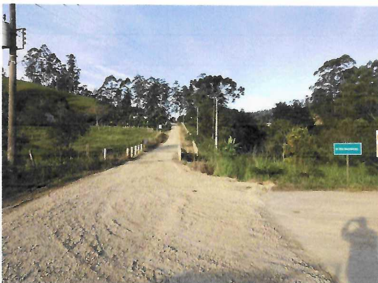
Imagem 22: Estrada na Localidade Rio Bandeira com material britado aplicado.
