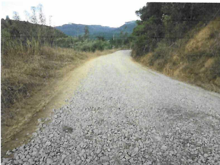
Imagem 23: Estrada na Localidade Rio Bandeira com material britado aplicado.
