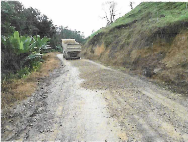
Imagem 10: Execução dos trabalhos de aplicação do material britado na estrada da Localidade Boa Esperança.
