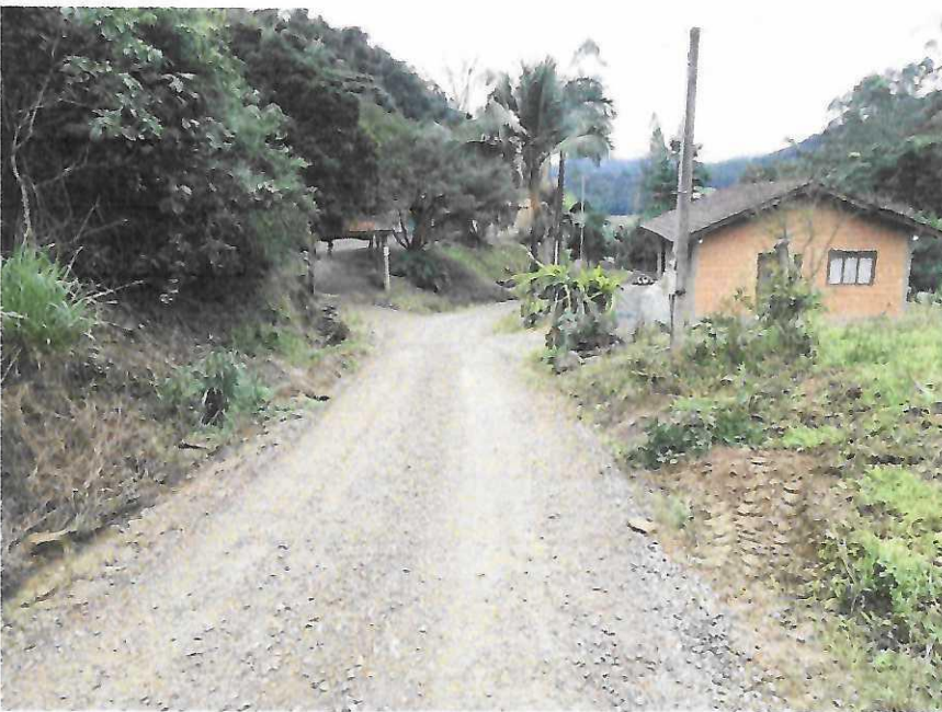
Imagem 17: Estrada na Localidade Boa Esperança com material britado aplicado.
