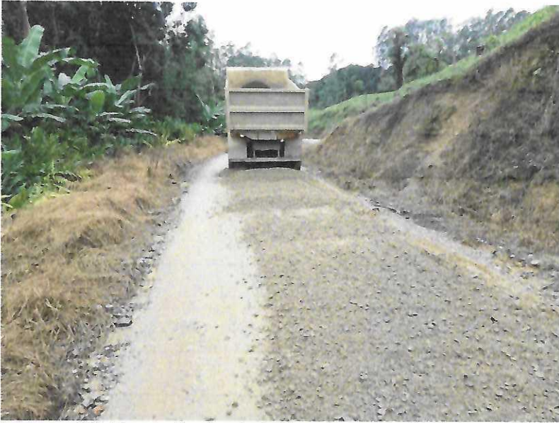
Imagem 12: Execução dos trabalhos de aplicação do material britado na estrada Localidade Boa Esperança.
