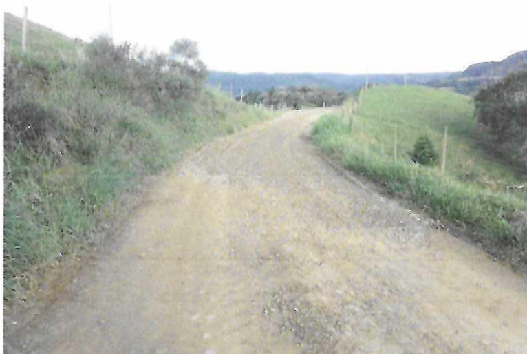
Imagem 26: Estrada na Localidade Rio Bandeira com material britado aplicado.
