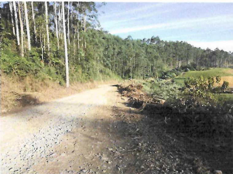
Imagem 29: Estrada na Localidade Rio Bandeira com material britado aplicado.
