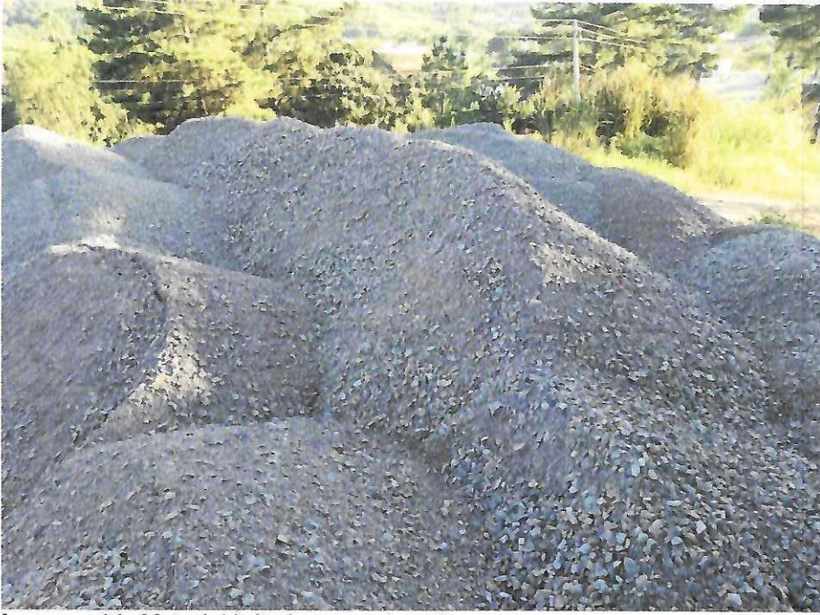
Imagem 02: Material britado recepcionado.
