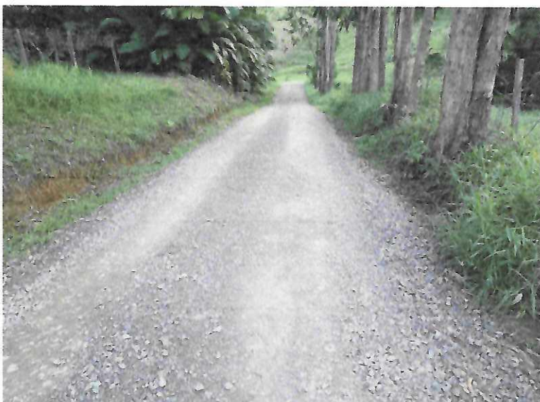
Imagem 27: Estrada na Localidade Rio Bandeira com material britado aplicado.
