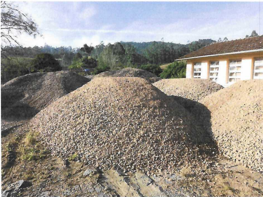
Imagem 05: Material britado recepcionado.
