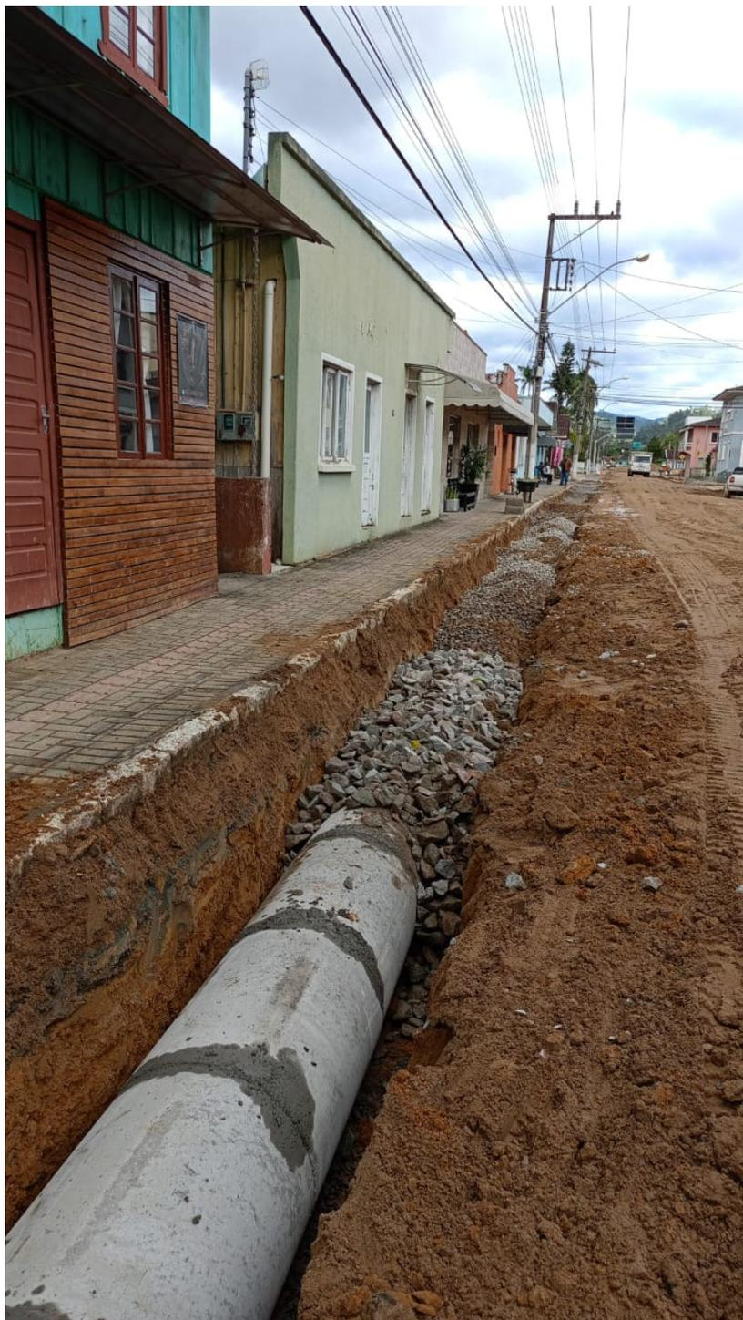
Imagem 08 – Terraplenagem e Drenagem Pluvial.
