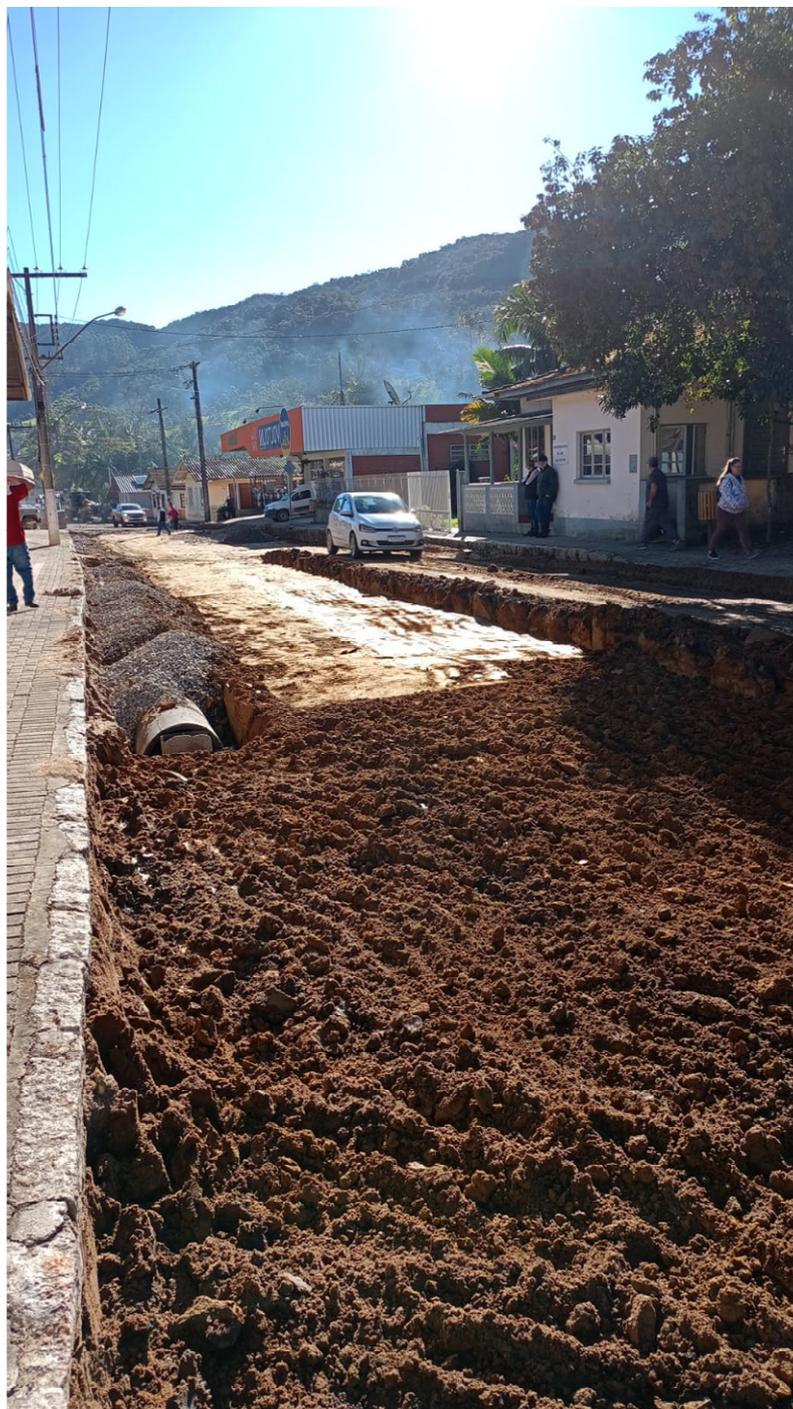
Imagem 07 – Terraplenagem e Drenagem Pluvial.
