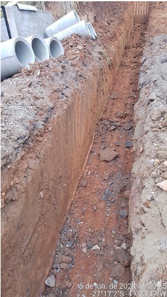
Imagem 15, Imagem 16 e imagem 17: Mobilização de equipamentos para obras de pavimentação, Escavação mecanizada, assentamento de tubo de concreto, camada de brita, reaterro.
