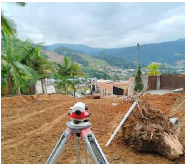
Imagem 07 e imagem 08: Serviços topográficos e nivelamento.
