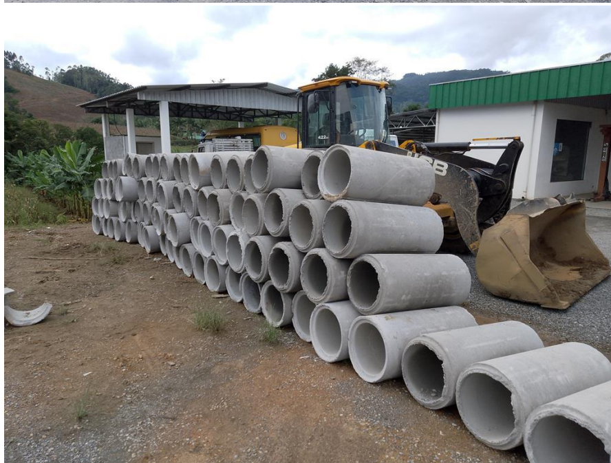
Imagem 03 e imagem 04: Tubos utilizados na obra.
