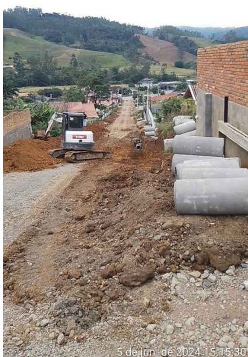
Imagem 13 e Imagem 14: Escavação mecanizada, assentamento de tubo de concreto, camada de brita, reaterro.
