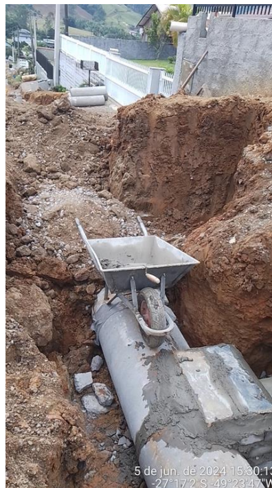
Imagem 24 e imagem 25: Caixa de captação, escavação mecanizada, assentamento de tubo de concreto, camada de brita, reaterro, assentamento de tubo de concreto rejuntados com argamassa.
