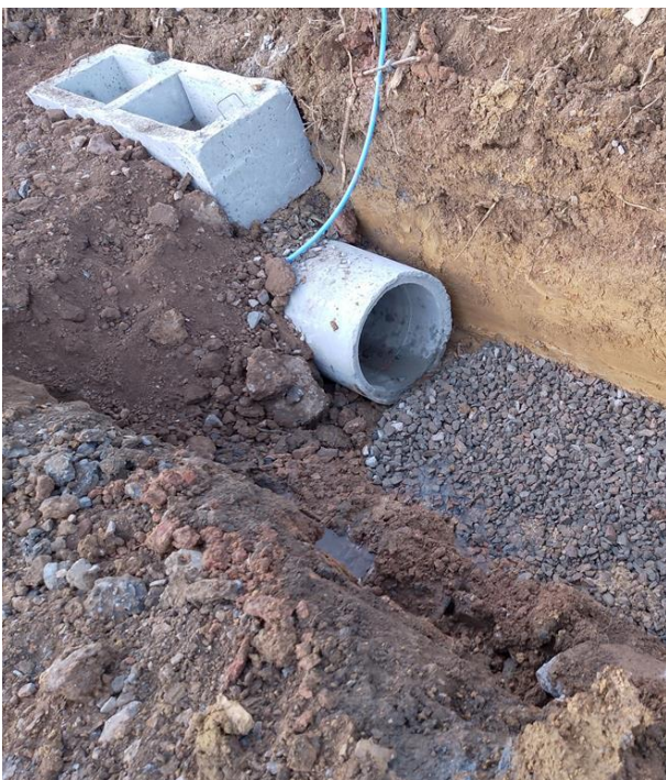
Imagem 24 e imagem 25: Caixa de captação, escavação mecanizada, assentamento de tubo de concreto, camada de brita, reaterro, assentamento de tubo de concreto rejuntados com argamassa.
