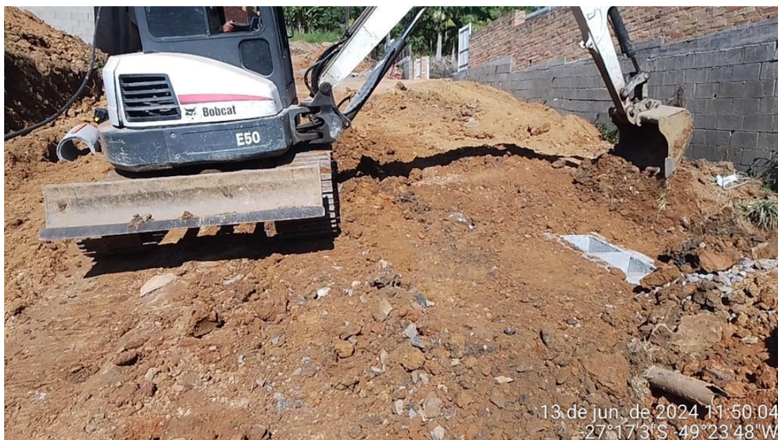
Imagem 23 e imagem 24: Caixa de captação com junção em alvenaria de tijolo maciço e concreto, escavação mecanizada, assentamento de tubo de concreto, camada de brita, reaterro.
