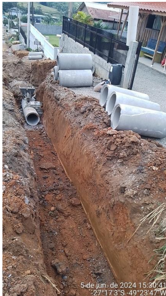
Imagem 15, Imagem 16 e imagem 17: Mobilização de equipamentos para obras de pavimentação, Escavação mecanizada, assentamento de tubo de concreto, camada de brita, reaterro.
