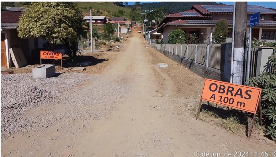
Imagem 11: Placa de identificação e sinalização de obra.
