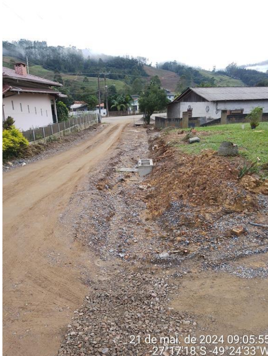
Imagem 13 e Imagem 14: Escavação mecanizada, assentamento de tubo de concreto, camada de brita, reaterro.
