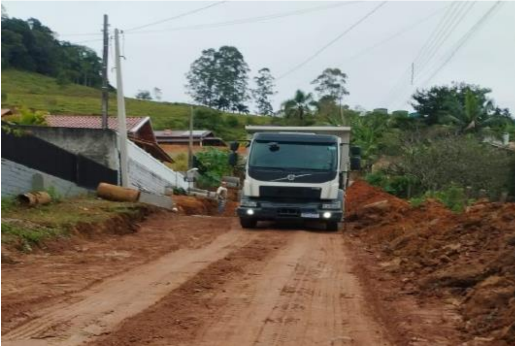
Imagem 26: Transporte de material com caminhão basculante.
