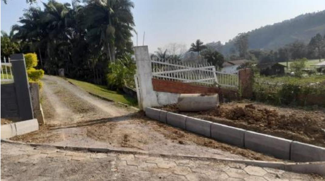
**Imagem 05:** Meio fio pré-moldado de concreto tipo 2 (reto) 6x6x30. Compactação mecânica, sem controle do GC e execução e compactação de base e ou sub-base com brita graduada simples – entradas das residências, lado direito.
