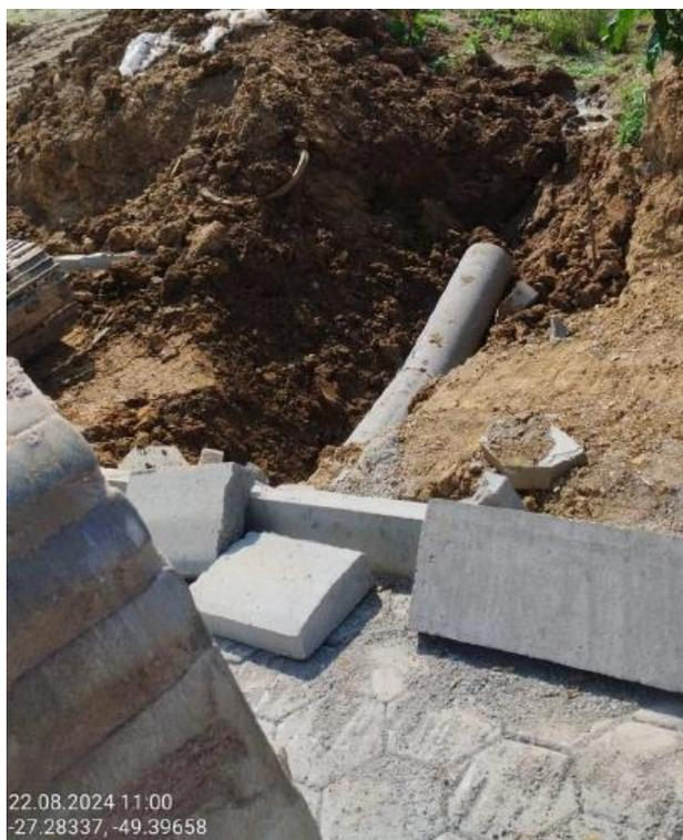
**Imagem 134:** Tudo de concreto D 200mm – drenagem.
