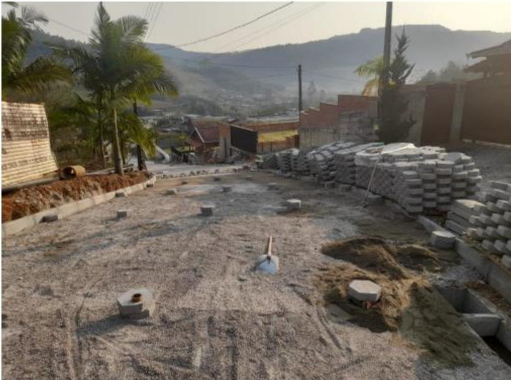
**Imagem 04:** Meio fio pré-moldado de concreto tipo 1 (arredondado) (6x10) x10x30 – prolongamento da rua.
