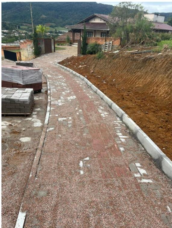
**Imagem 07:** Execução de pavimento em piso intertravado, com bloco retangular cor natural e paver vermelho podotátil e meio fio pré-moldado de concreto tipo 2 – prolongamento da rua.
