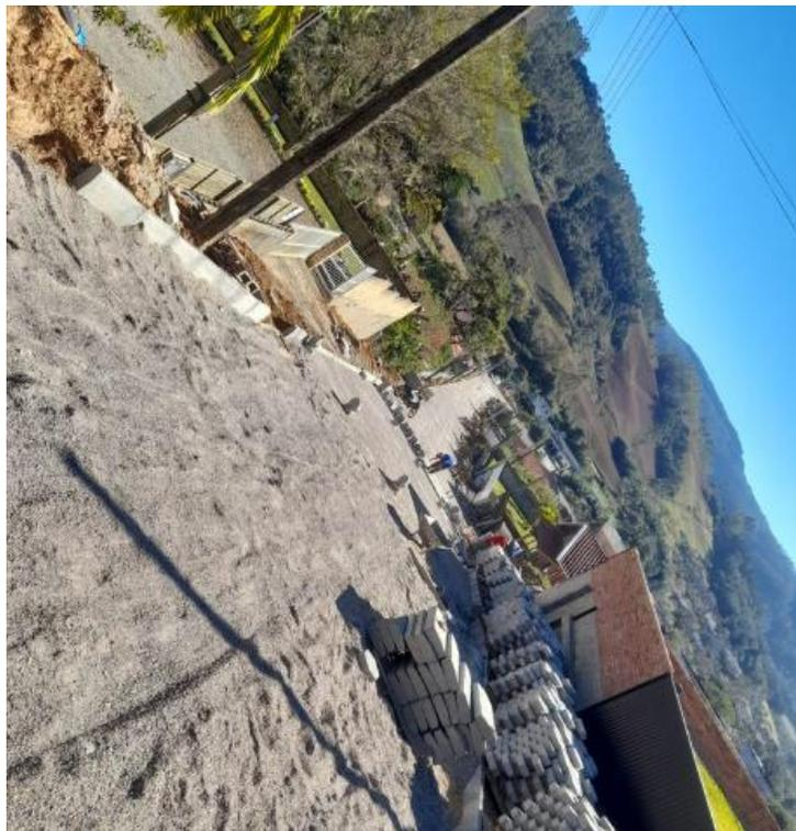
**Imagem 09:** Compactação mecânica, sem controle do GC e execução e compactação de base e ou sub-base com brita graduada simples – prolongamento da rua.
