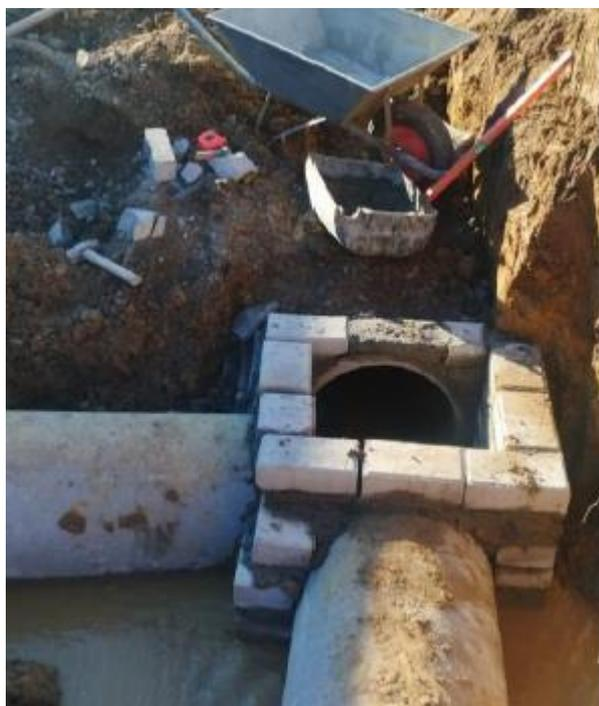
**Imagem 11:** Caixa de junção em bloco de concreto – drenagem.
