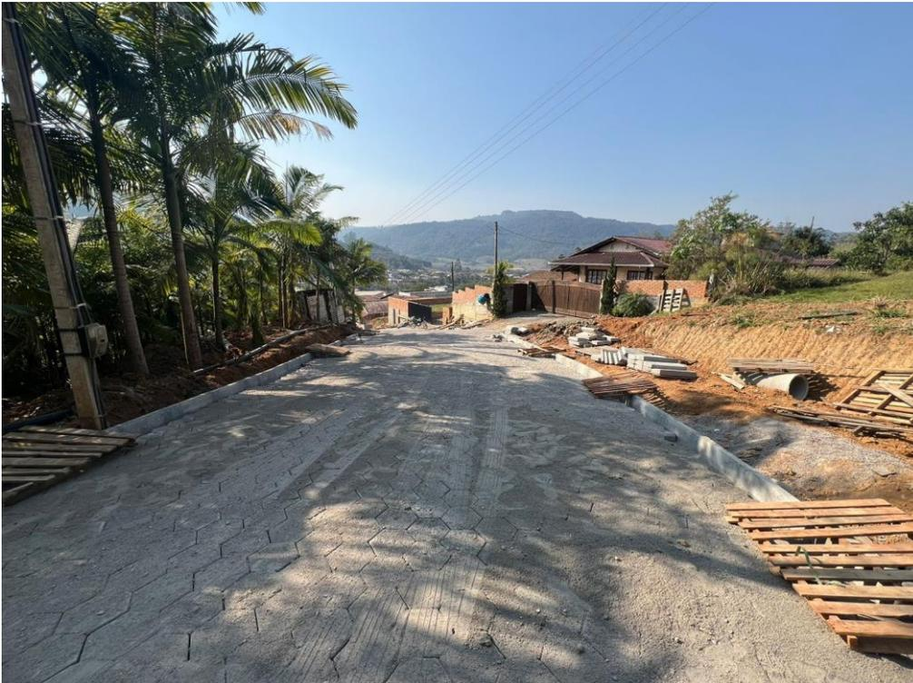
**Imagem 06:** Execução de pavimento em piso intertravado, com bloco sextavado de 25 x 25 cm, espessura 8 cm – prolongamento da rua.
