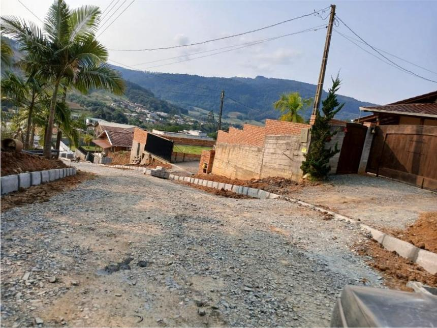
**Imagem 03:** Execução e compactação de base e ou sub-base com brita graduada simples – prolongação da rua.
