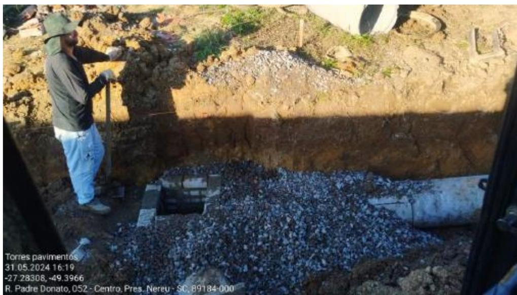
**Imagem 12:** Caixa de captação com junção em alvenaria – drenagem.
