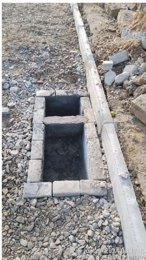
Imagem 90, imagem 91 e imagem 92: Caixa de captação com junção em alvenaria de tijolo maciço e concreto para tubos de DN 600mm, incluindo materiais, serviço, escavação e reaterro. Caixa de junção em bloco de concreto para tubos de dn 600mm, incluindo materiais e serviço.
