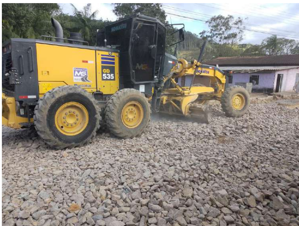
Imagem 15: espalhamento do material macadame seco.
