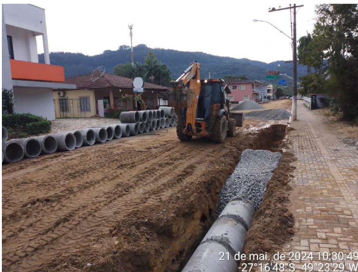
Imagem 25: Escavação, transporte de material e reaterro. Assentamento de tubos de concreto DN 600mm com junta em argassa.
