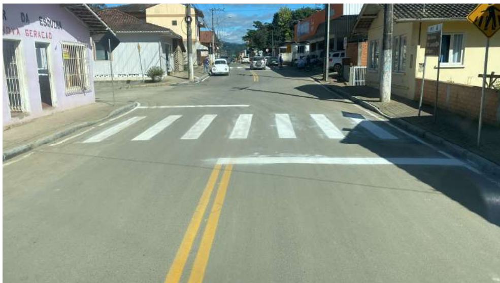
Imagem 13 – Execução do sistema de Sinalização Viária – Horizontal e Vertical
