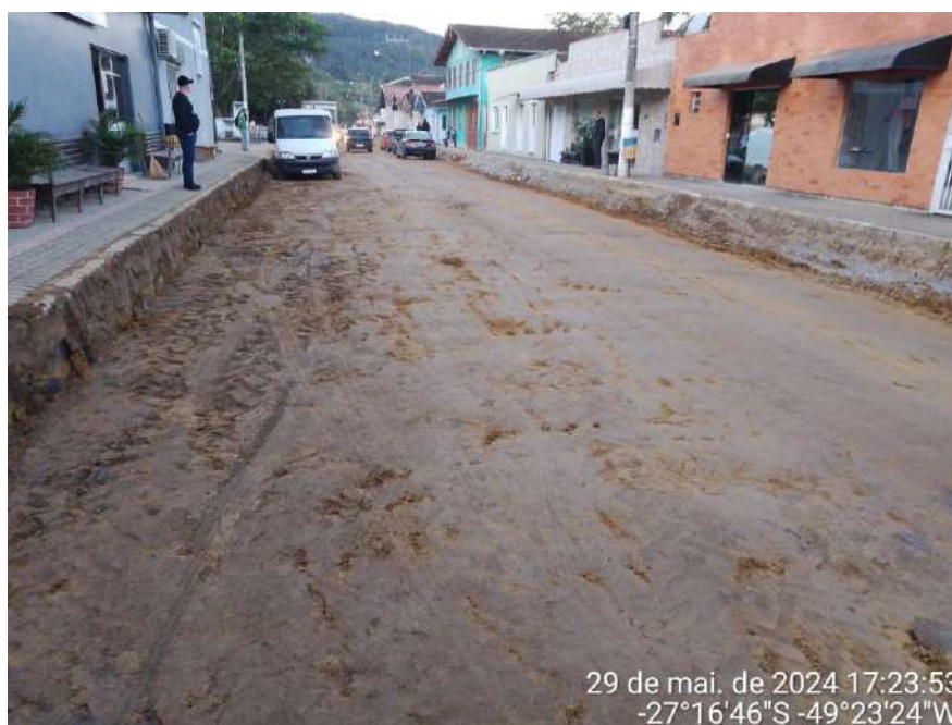
Imagem 75: Regularizado e compactado subleito com uso de motoniveladora, rolo compactador vibratório.
