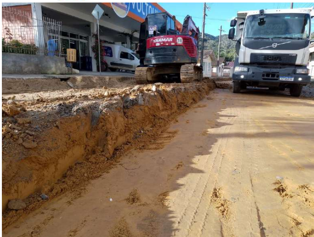
Imagem 14: Escavação horizontal, incluindo carga e descarga.
