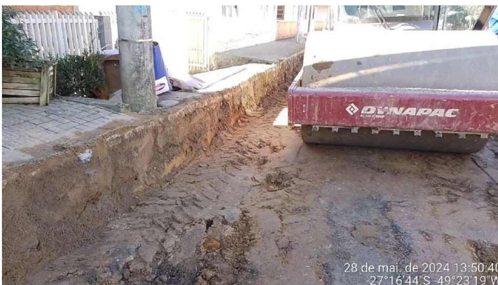
Imagem 53 e imagem 54: Regularização e compactação de subleito de solo predominantemente argiloso com uso de rolo compactador vibratório.
