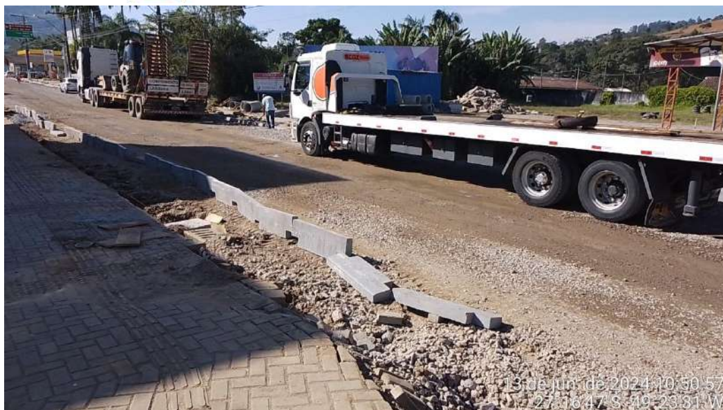
Imagem 100: Escavação, material e serviço de meio fio.
