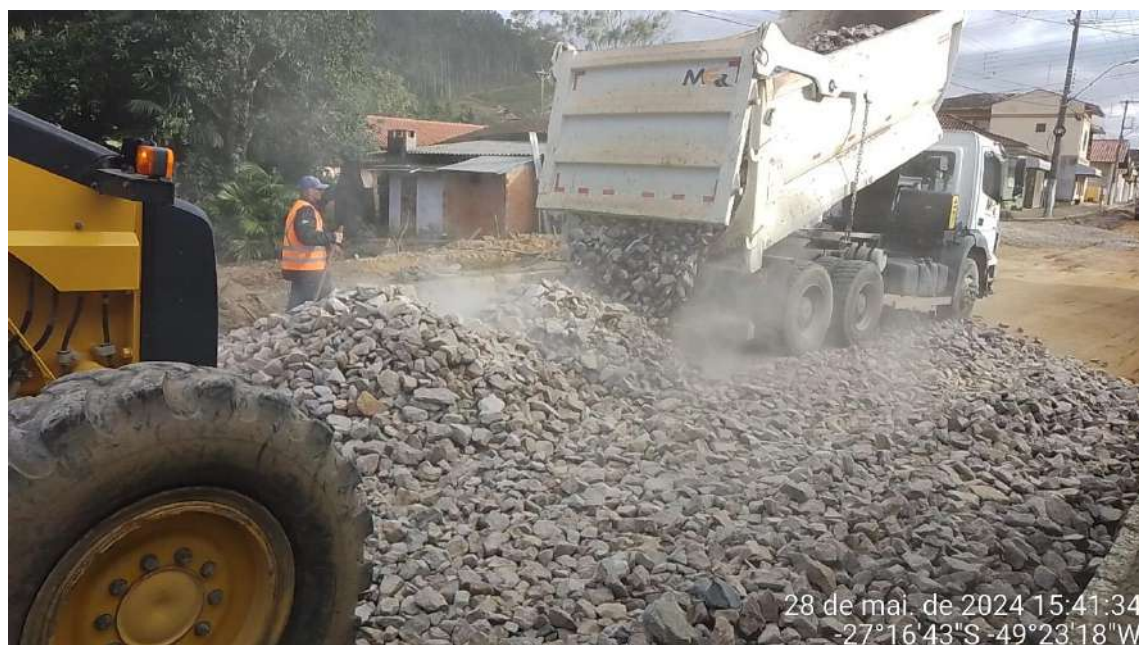
Imagens 59 e imagem 60: Aplicação de camada de macadame seco, com uso de caminhão basculante, distribuidor de agregados, materiais e transporte.
