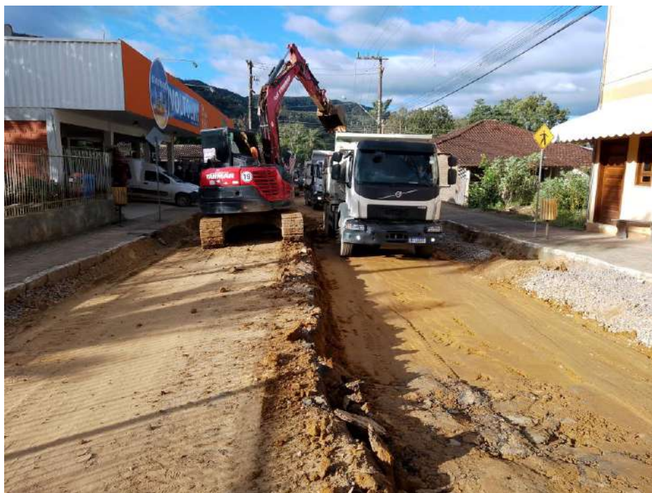
Imagem 19: Escavação horizontal, incluindo carga e descarga. Transporte com caminhão basculante, em via urbana em leito natural.
