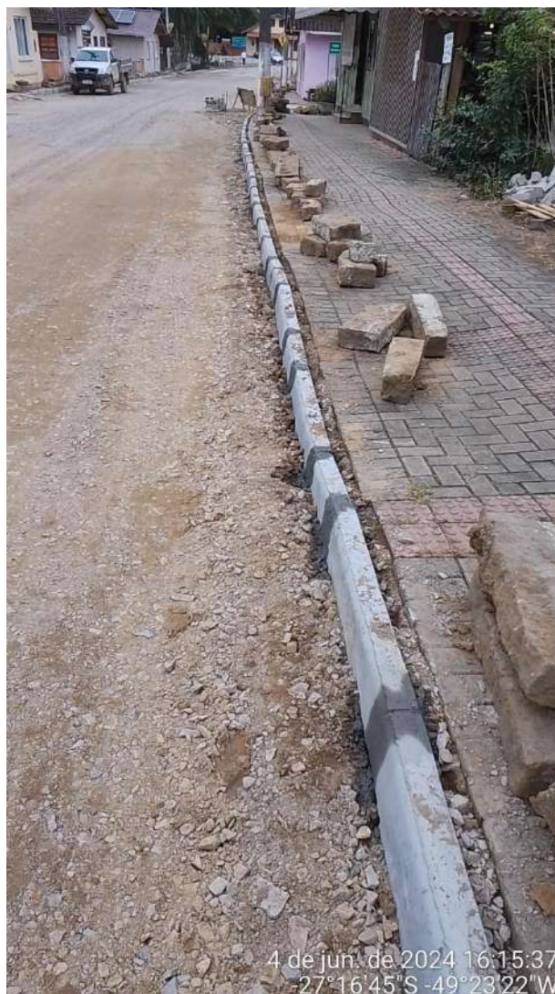
Imagem 82 e imagem 83: Executado e compactado base e ou sub base com brita graduada simples. Meios-fios pré moldado de concreto colocados e rejuntado com argamassa.
