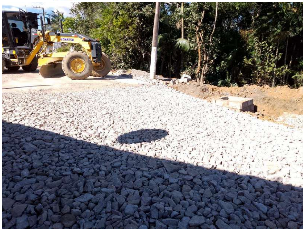
Imagem 12: Execução e compactação de base e ou sub base com macadame seco.
