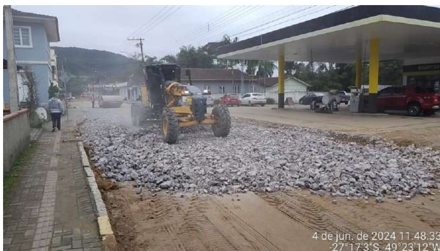
Imagem 78 e Imagem 79: Transporte de material, regularização e compactação de subleito de solo predominantemente argiloso. Execução e compactação de base e ou sub base com macadame seco.
