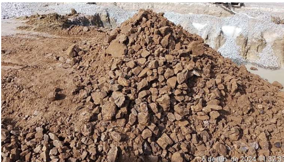
Imagem 05 e imagem 06: Material descarregado para reforço do subleito de até 1,50 m de profundidade.
