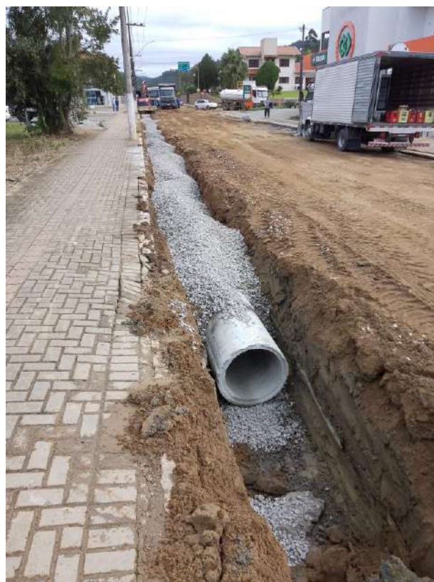
Imagem 09 e Imagem 10: Tubo de concreto, Assentamento de tubo, Camada de brita, Reaterro das valas com brita.
