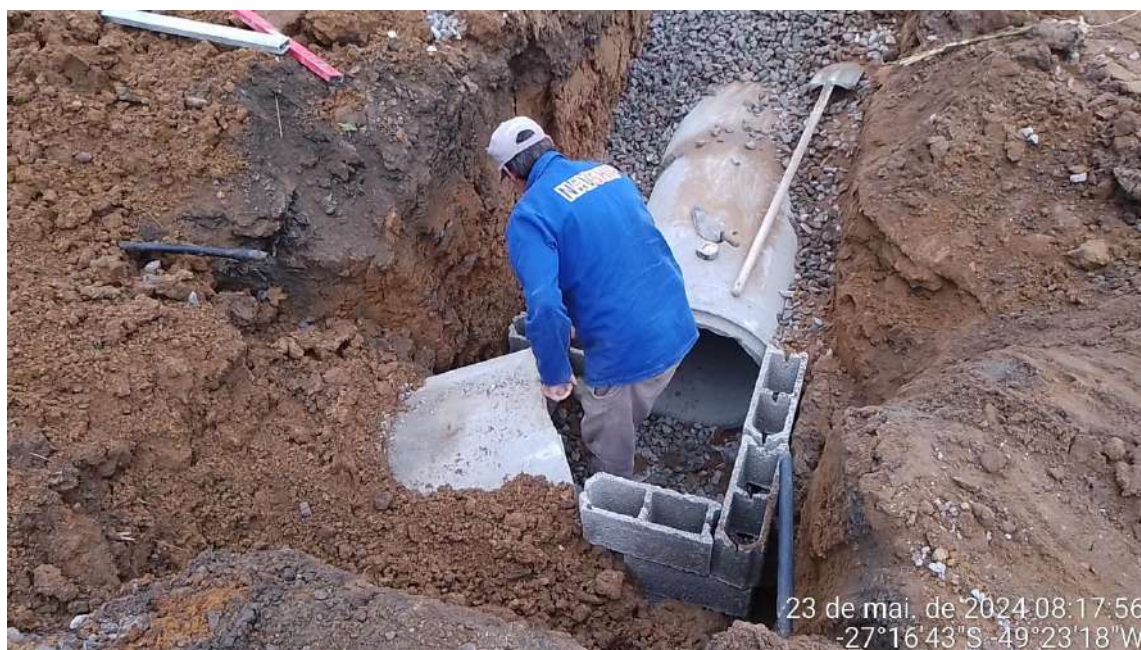
Imagem 41: Execução de caixa de junção.
