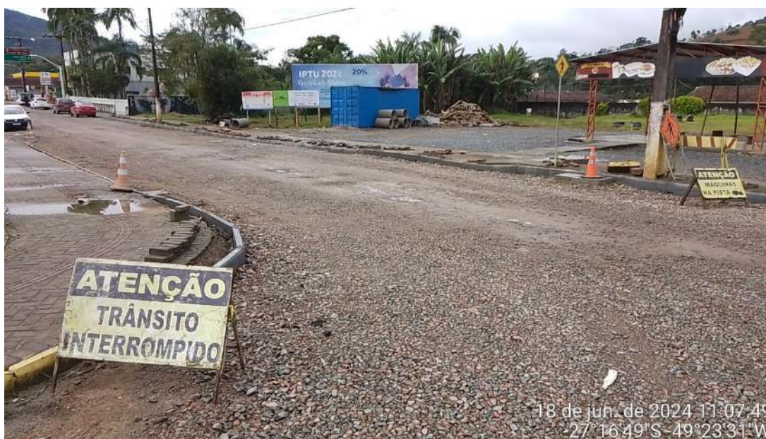
Imagem 107: Sinalização de obra. camada de brita graduada compactada.
