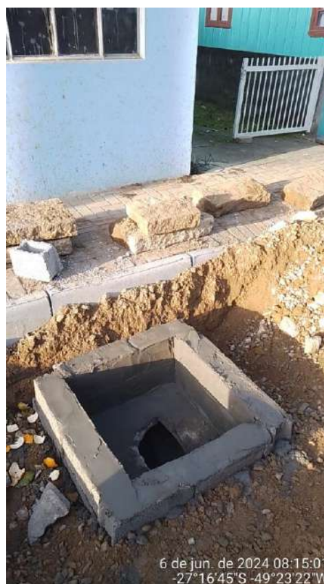
Imagem 90, imagem 91 e imagem 92: Caixa de captação com junção em alvenaria de tijolo maciço e concreto para tubos de DN 600mm, incluindo materiais, serviço, escavação e reaterro. Caixa de junção em bloco de concreto para tubos de dn 600mm, incluindo materiais e serviço.
