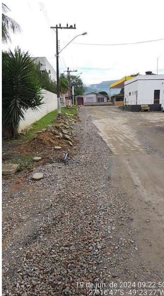
Imagem 34 e imagem 35: Reaterro das valas com brita, fornecimento e colocação.
