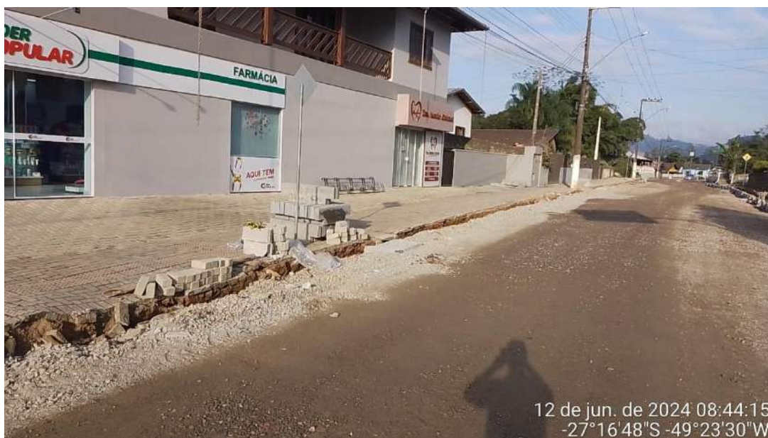
Imagem 99: Execução e compactação de base e ou sub base com brita graduada simples.
