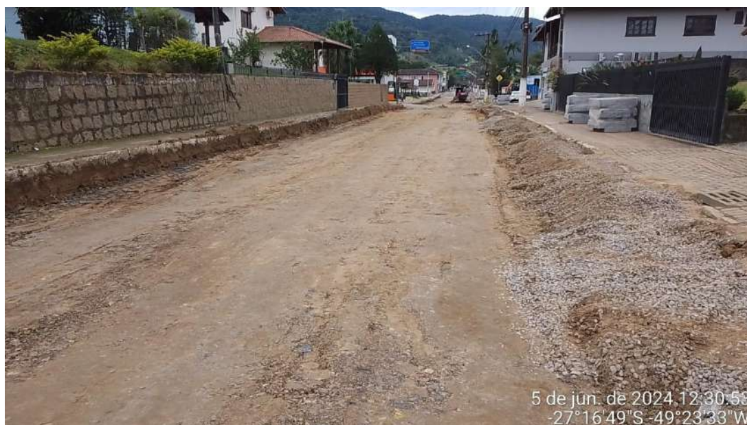
Imagem 87: Região escavada antes de receber camadas de base com macadame seco e brita graduada simples, com valas de tubulação reaterradas.
