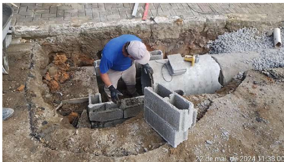
Imagem 32: Execução de caixa de inspeção
