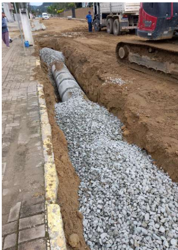
Imagem 03 e Imagem 04: Tubo de concreto, Assentamento de tubo, Camada de brita, Reaterro das valas com brita.
