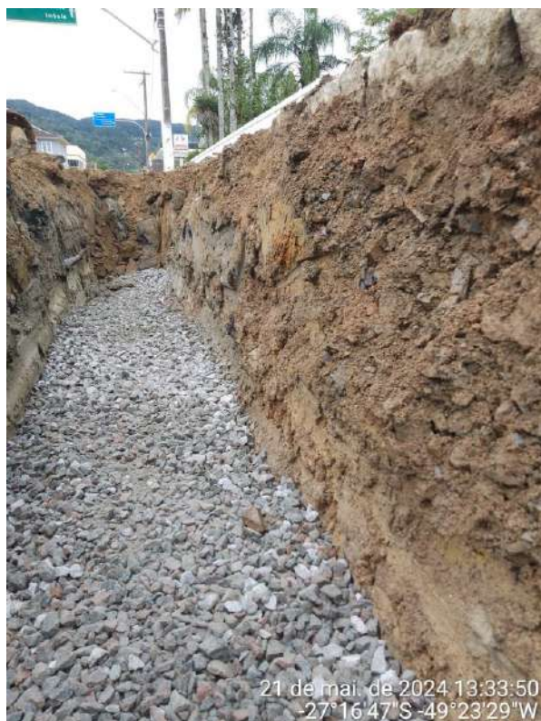
Imagem 28, imagem 29 imagem 30: Camada de brita para assentamento de tubo. Reaterro de valas.
