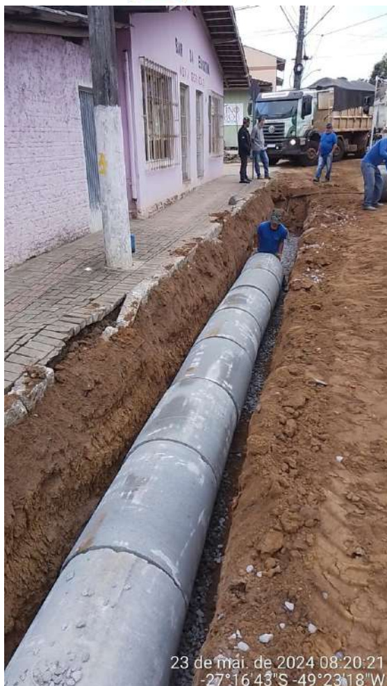
Imagem 42 e imagem 43: Tubos de concreto, vala escavada, junta de argamassa.
