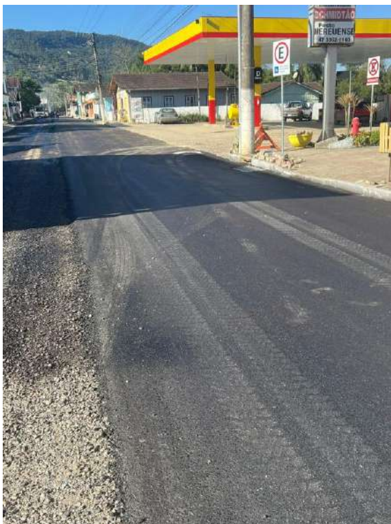
Imagem 06: Execução de pavimento com aplicação de concreto asfáltico, camada de rolamento - exclusive carga e transporte. Af_11/2019.
