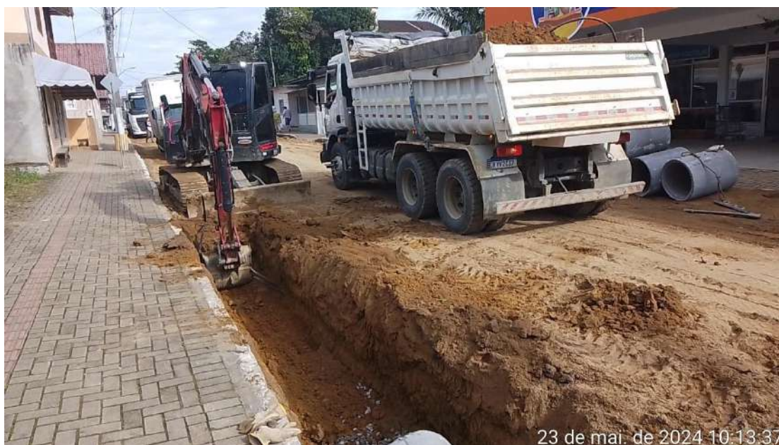
Imagem 46: Escavação mecanizada de vala, transporte de material com caminhão basculante.
