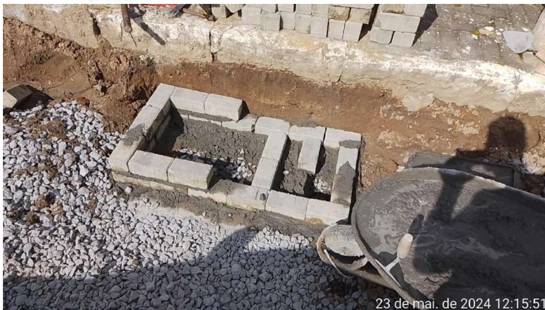
Imagem 49: Execução caixa de captação com junção em alvenaria de tijolo maciço e concreto
