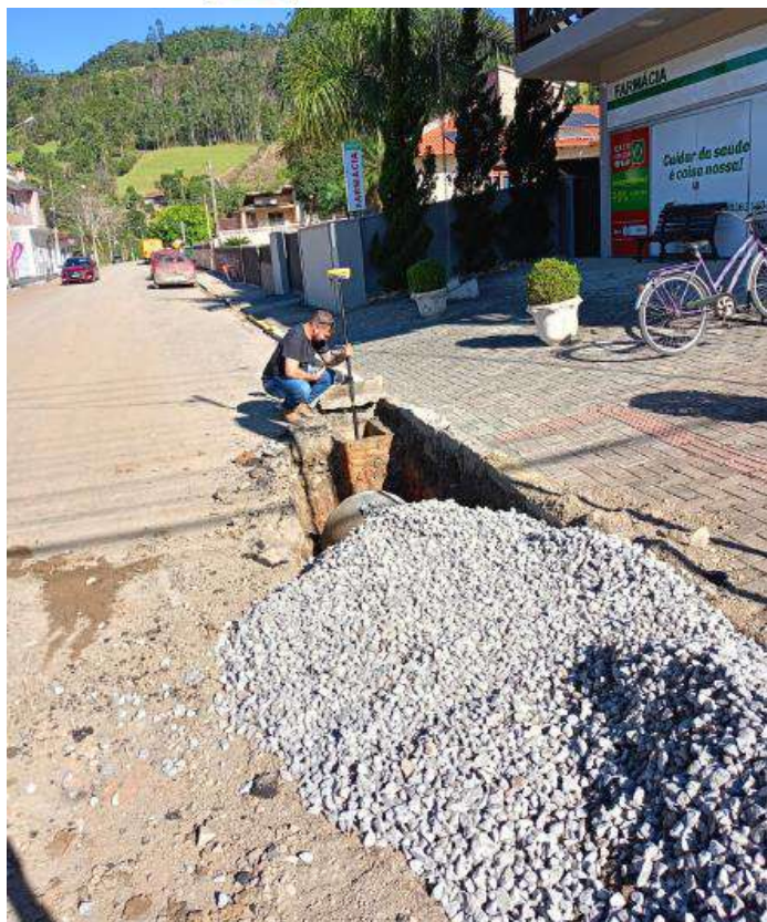
Imagem 05: Locação e nivelamento de rede pluvial com auxílio de equipamento topográfico.
