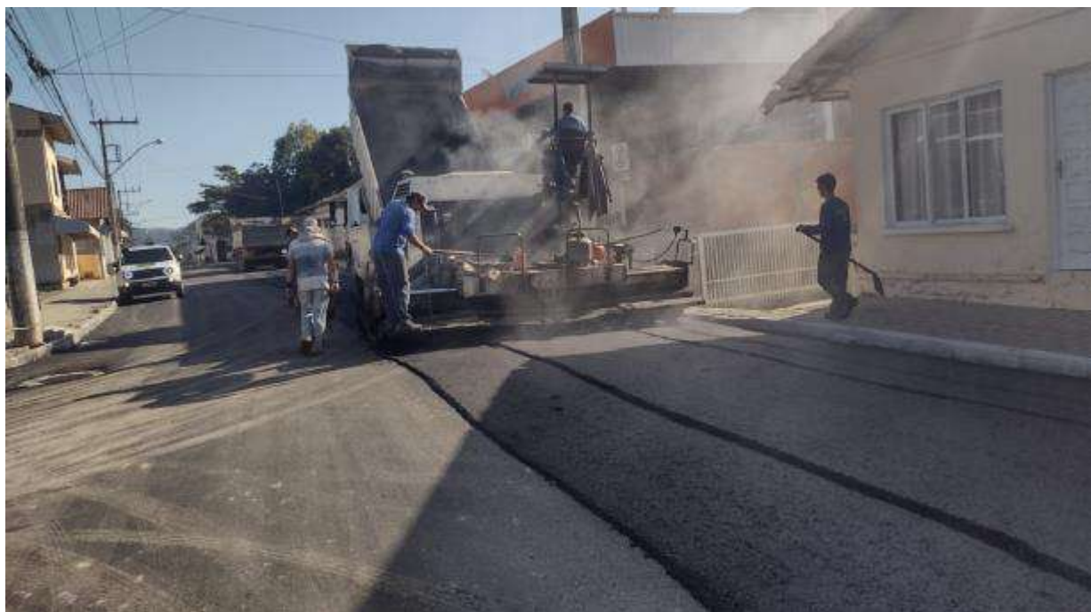
Imagem 07: Execução de imprimação com asfalto diluído cm-30. Mobilização de equipamentos para obras de pavimentação asfáltica. Desmobilização de equipamentos para obras de pavimentação asfáltica.
