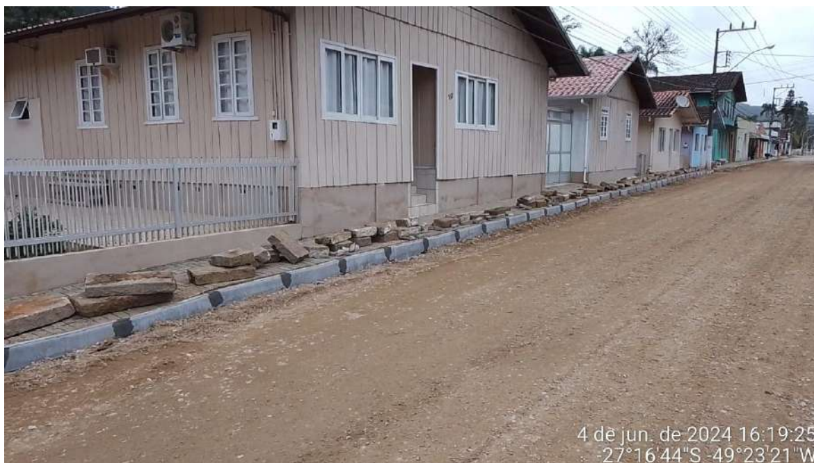
Imagem 84 e imagem 85: Executado e compactado base e ou sub base com brita graduada simples. Meios-fios pré moldado de concreto colocados e rejuntado com argamassa.
