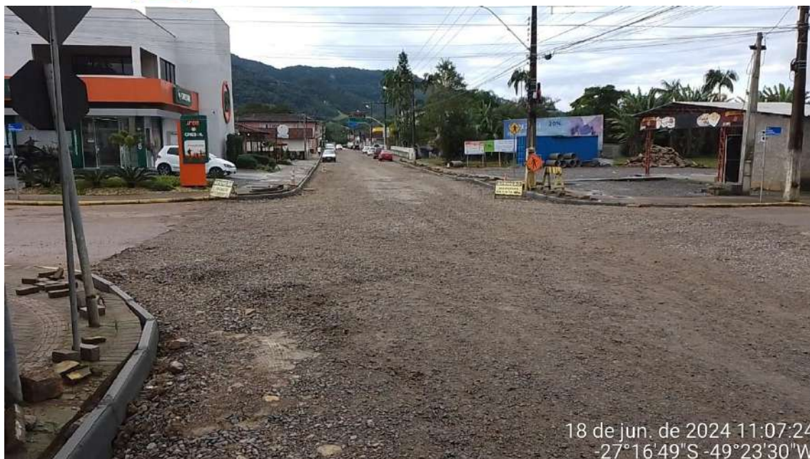
Imagem 106: Meios-fios colocados. Camada de brita graduada compactada.
