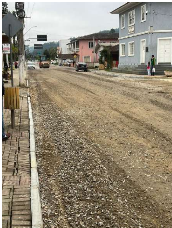
Imagem 10: Meio fio pré-moldado de concreto tipo 1 (arredondado) (6x10)x10x30, com fornecimento e instalação.
