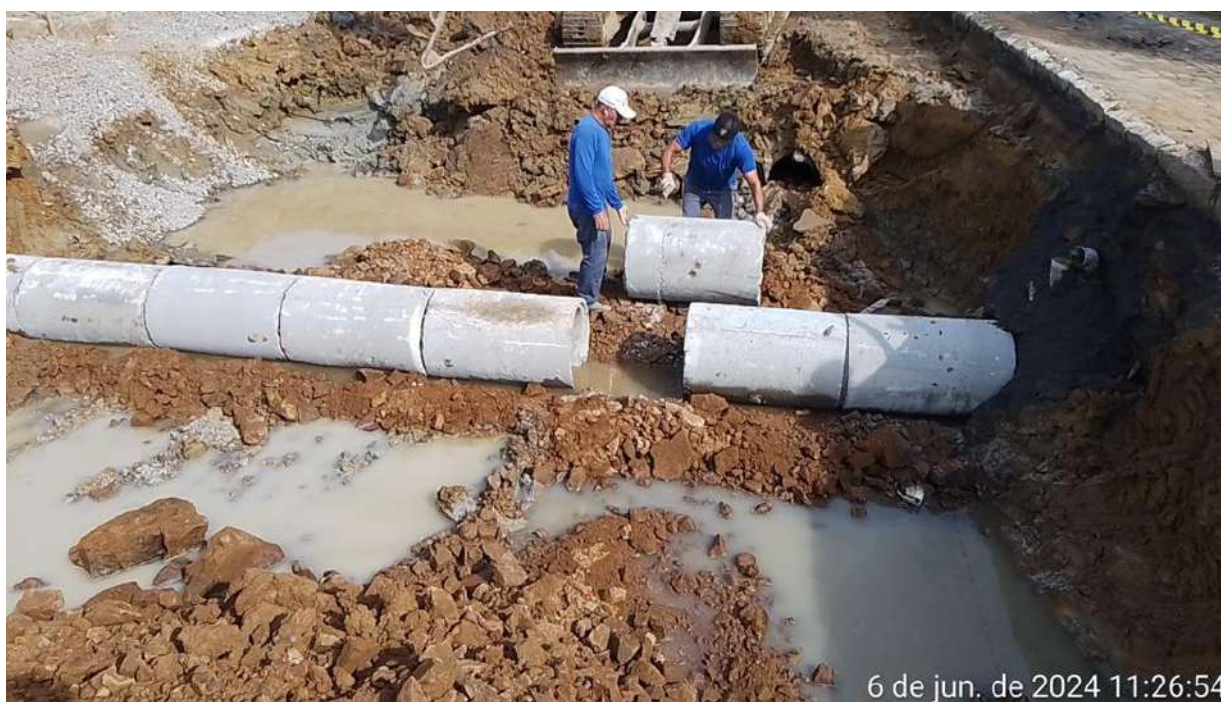
Imagem 09 e imagem 10: Assentamento de tubo de concreto dn 500mm. Observa-se área executada escavação horizontal, incluindo carga e descarga com trator de esteiras
