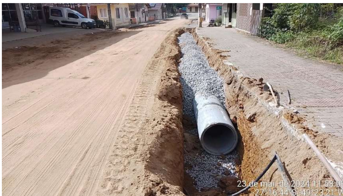
Imagem 47 e imagem 48: Tubo de concreto, Assentamento de tubo, Camada de brita, Reaterro das valas com brita.
