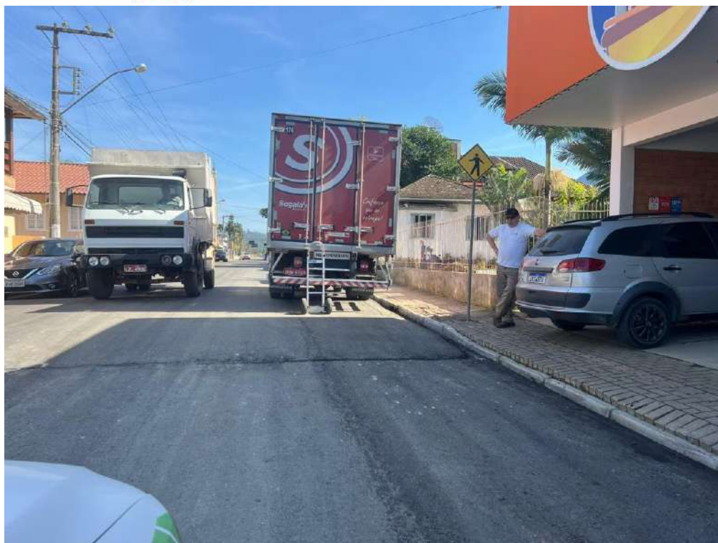
Imagem 09: Faixa elevada executada.
