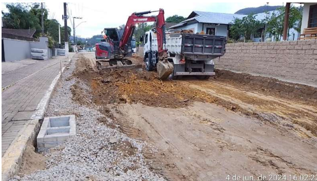
Imagem 80: Escavação horizontal, incluindo carga e descarga em solo com trator de esteiras, transporte com caminhão basculante em via urbana em leito natural.
