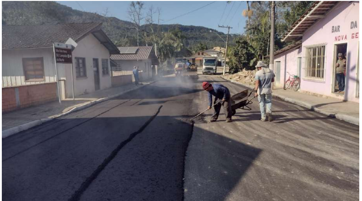
Imagem 03 – Aplicação da Camada asfáltica
