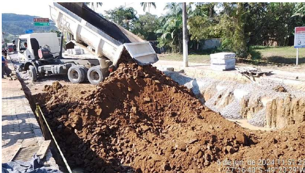
Imagem 17: Transporte com caminhão basculante em via urbana em leito natural.
