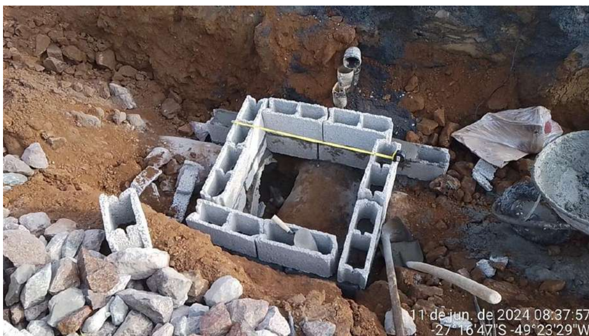
Imagem 26 e imagem 27: Construção de Caixa de inspeção em blocos de concreto. Previstas na planilha de aditivo.
