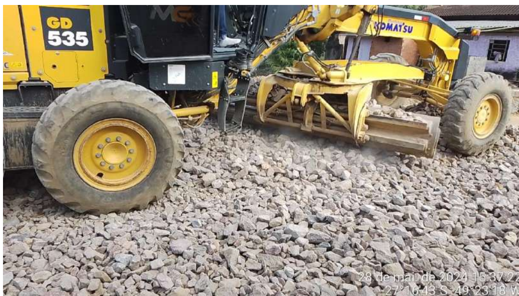
Imagem 57 e imagem 58: Aplicação de camada de macadame seco, com uso de caminhão basculante, distribuidor de agregados, materiais e transporte.
