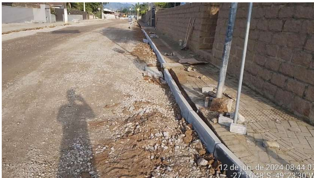
Imagem 98: Execução e compactação de base e ou sub base com brita graduada simples. Instalação de meios-fios.
