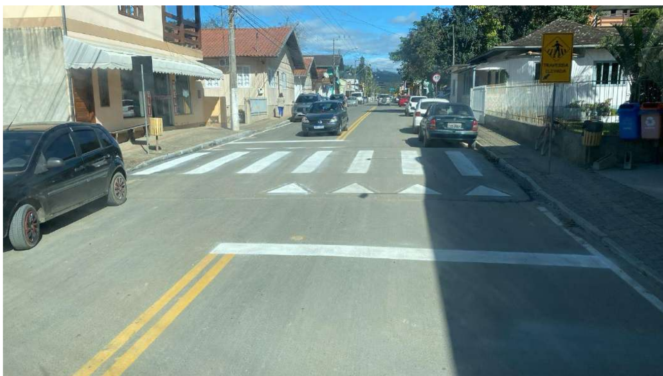
Imagem 14: Placa de regulamentação e ou advertência vertical: retangular (60x96cm) com chapa de aço e poste em aço galvanizado, chumbada em sapata de concreto. Placa de regulamentação e ou advertência
