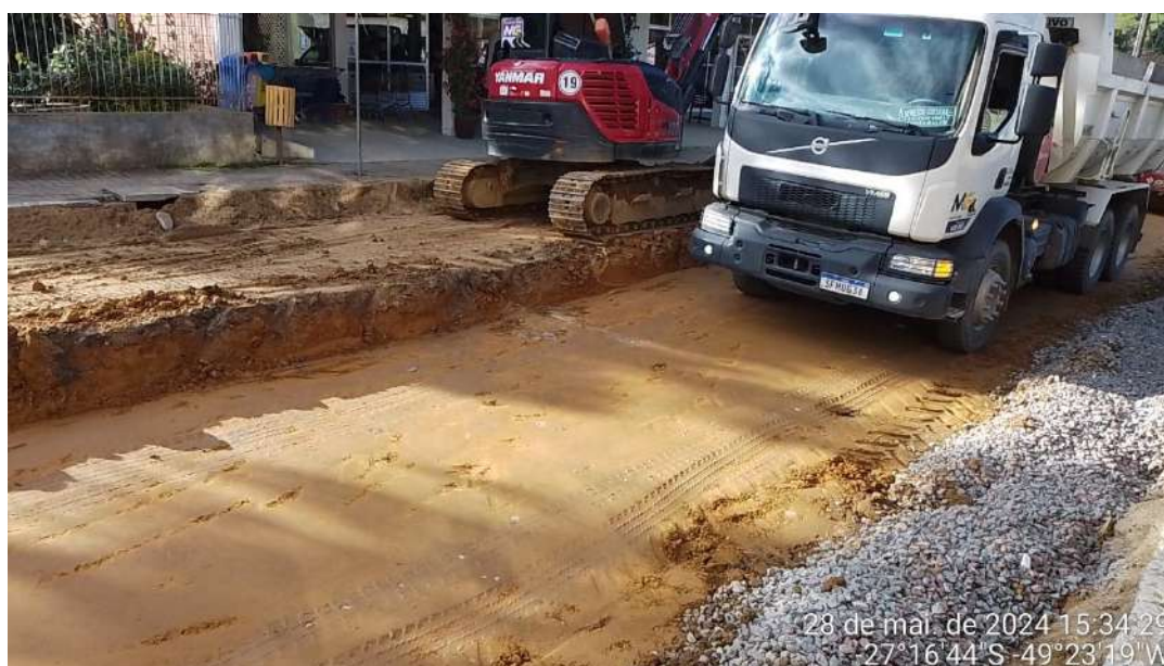
Imagem 56: Regularização e compactação de subleito de solo predominantemente argiloso com uso de rolo compactador vibratório.
