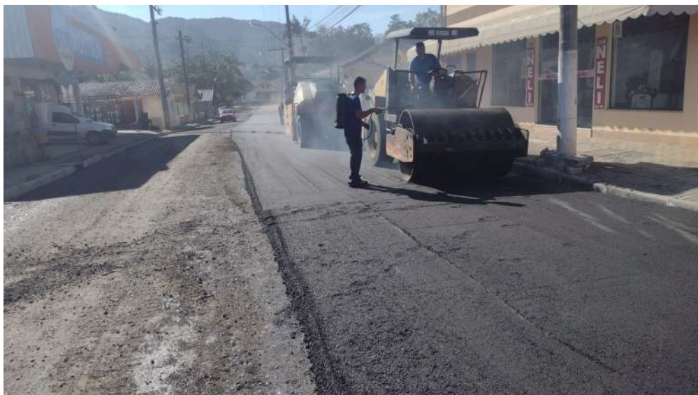
Imagem 07 – Aplicação da Camada Asfáltica e Compactação
