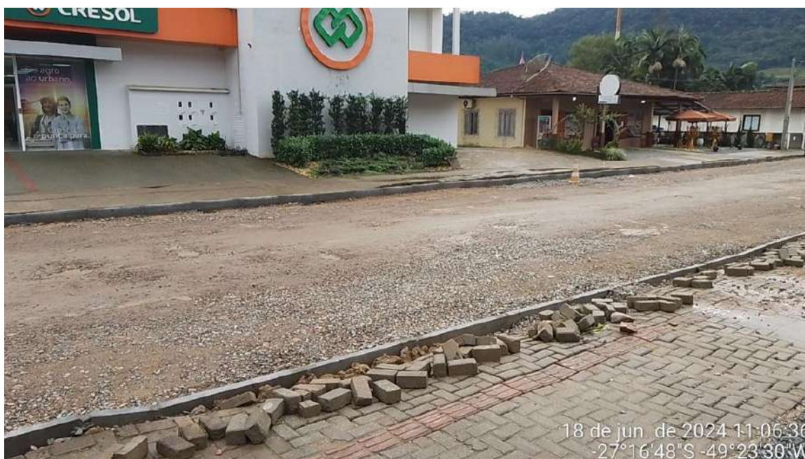
Imagem 20 e imagem 21: Situação da região entre estaca 03 e 07 na Avenida Erico Torres após etapas concluídas de execução e compactação de reforço de subleito e drenagem.
