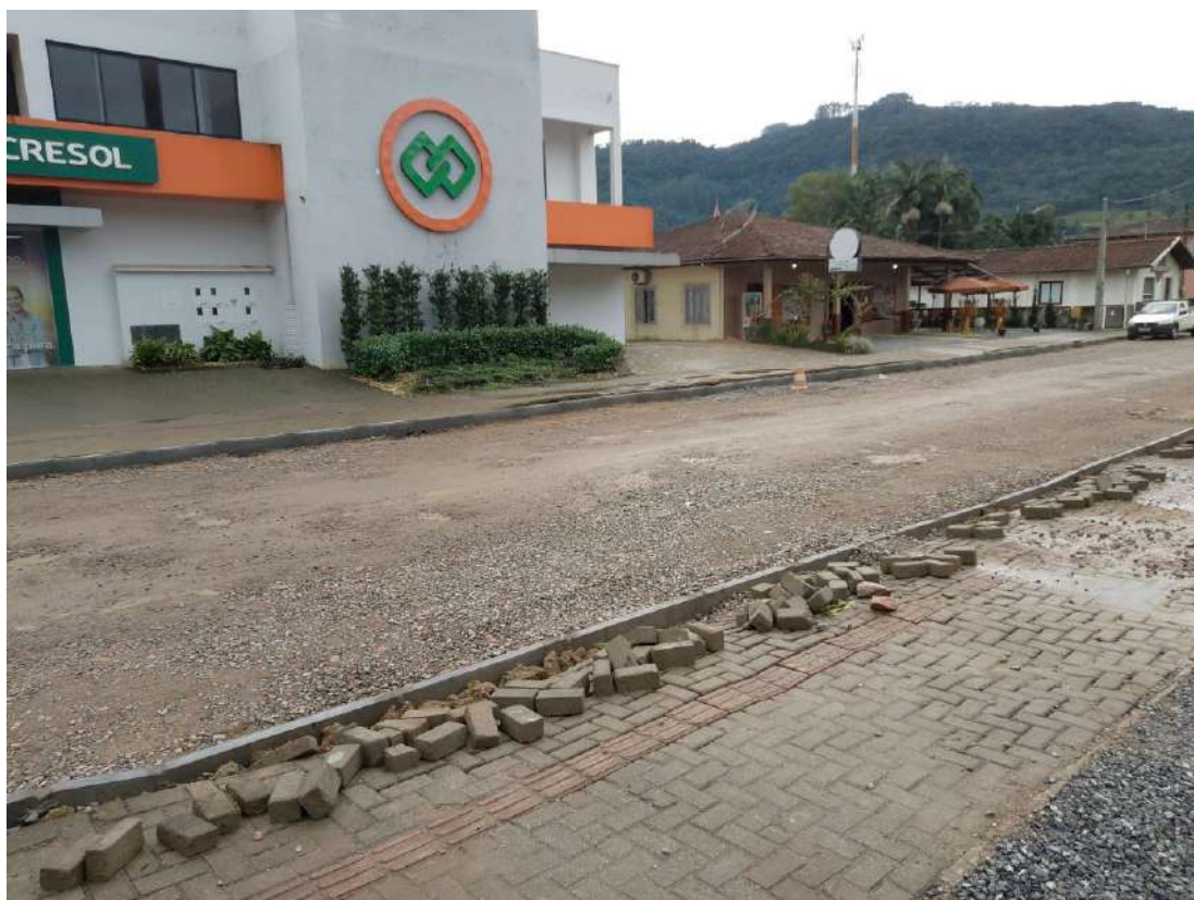
Imagem 109: Meios-fios colocados. Camada de brita graduada compactada.
