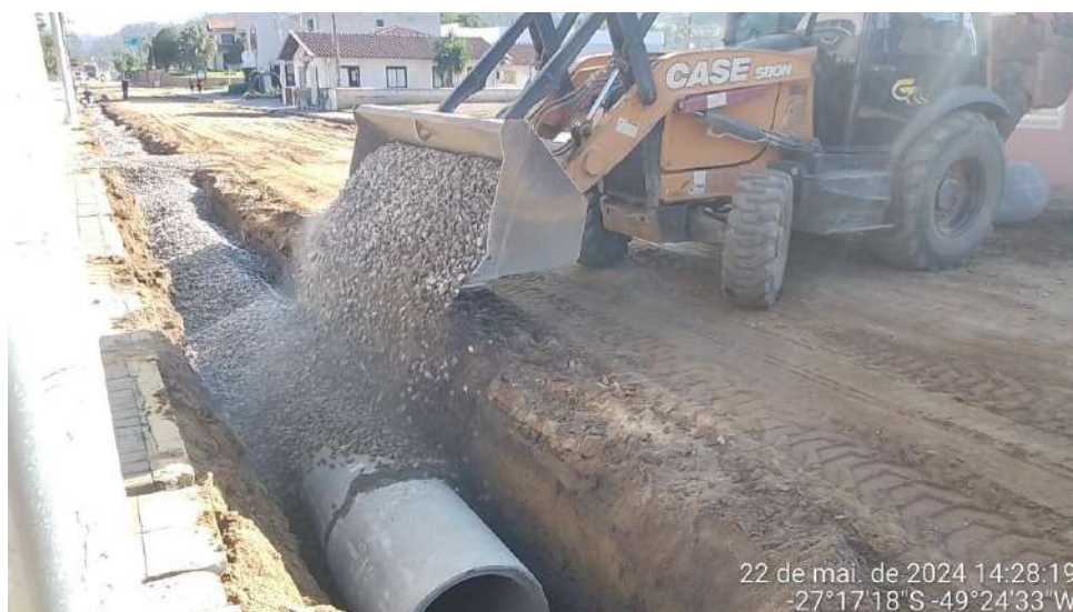
Imagem 37: Reaterro de vala.
