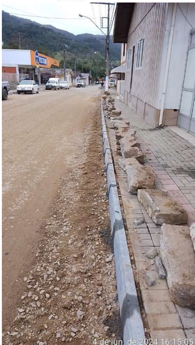
Imagem 82 e imagem 83: Executado e compactado base e ou sub base com brita graduada simples. Meios-fios pré moldado de concreto colocados e rejuntado com argamassa.
