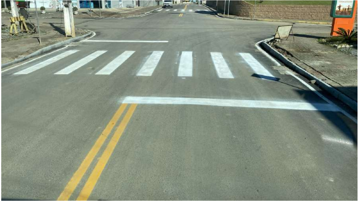
Imagem 11 – Execução do sistema de Sinalização Viária – Horizontal e Vertical
