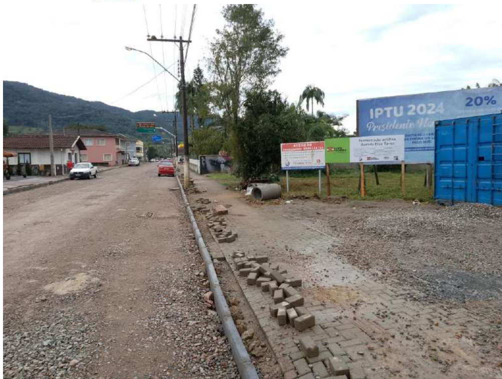
Imagem 01, Imagem 02: Placa de identificação e sinalização de obra.
