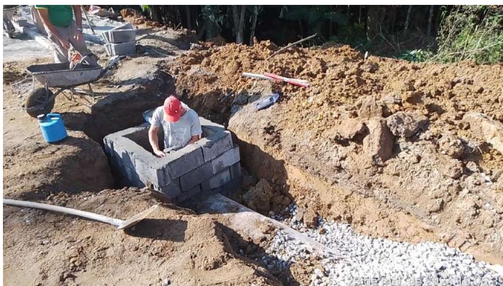
Imagem 44: Execução de caixa de junção.
