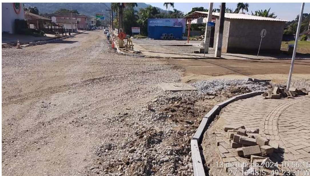
Imagem 103: Base e sub base com brita graduada simples executada e compactada. Colocação de meios-fios Pré moldado de concreto.
