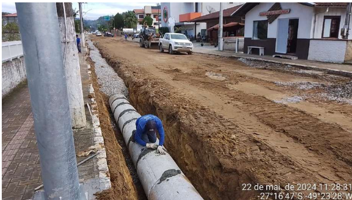
Imagem 31: Execução de junta em argamassa, incluindo materiais e serviço.
