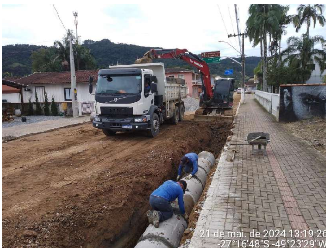
Imagem 26 e imagem 27: Escavação e transporte de material. Assentamento de tubos de concreto DN 600mm com junta em argamassa, incluindo materiais e serviço.
