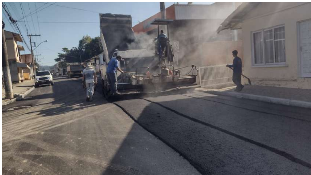
Imagem 04 – Aplicação da Camada asfáltica
