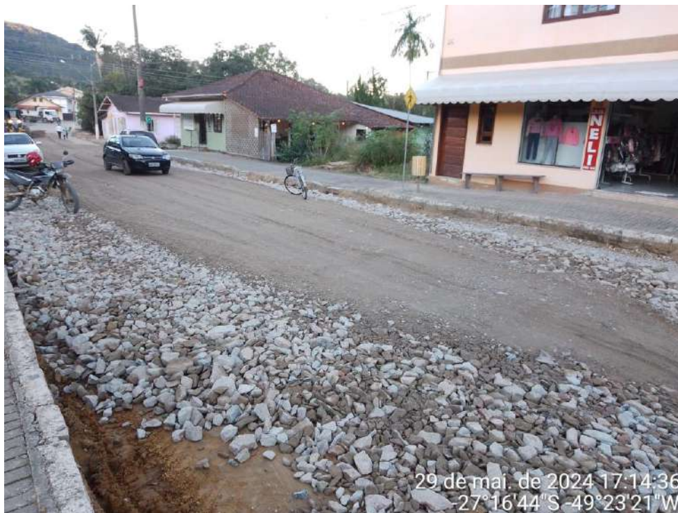
Imagem 69: Aplicação camada de brita graduada simples sobre camada de macadame seco.
