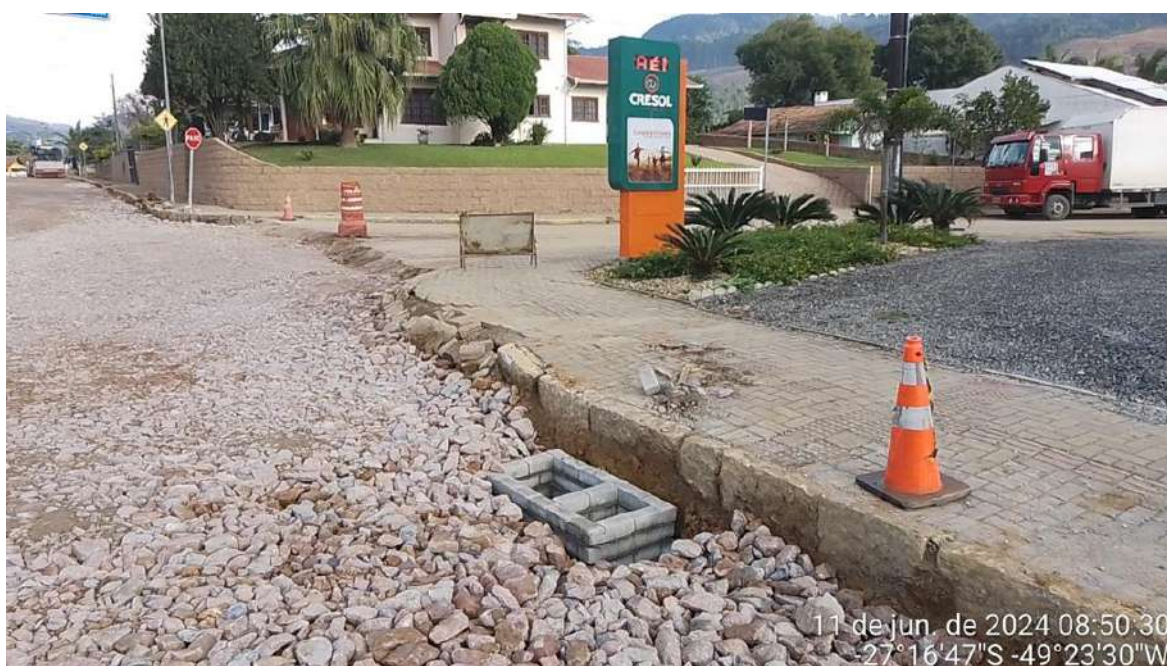
Imagem 22 e imagem 23: Caixas de captação, com junção em alvenaria de tijolo maciço e concreto, incluindo materiais, serviço, escavação e reaterro. Previstas na planilha do aditivo.
