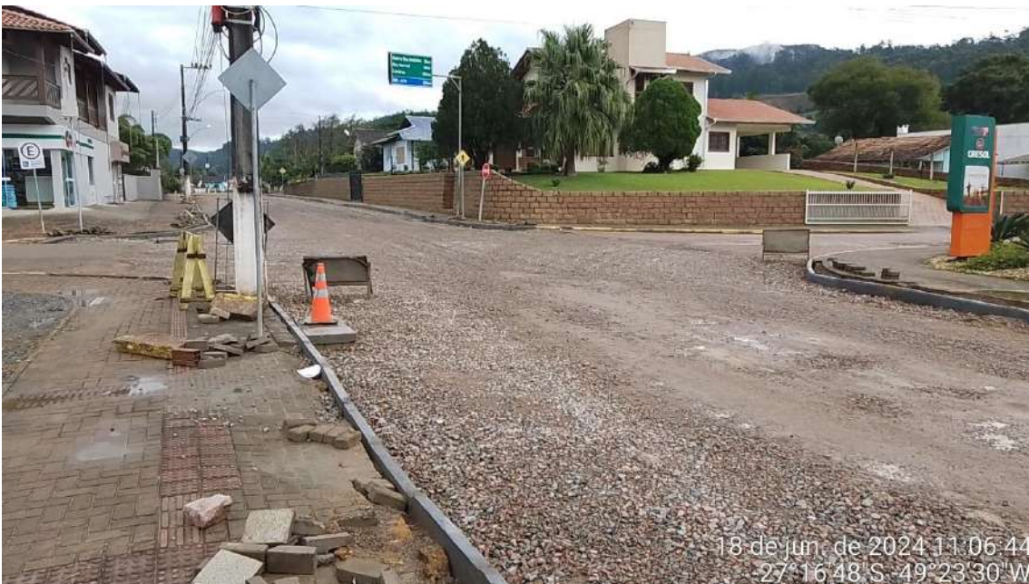
Imagem 105: Meios-fios colocados. Camada de brita graduada compactada.
