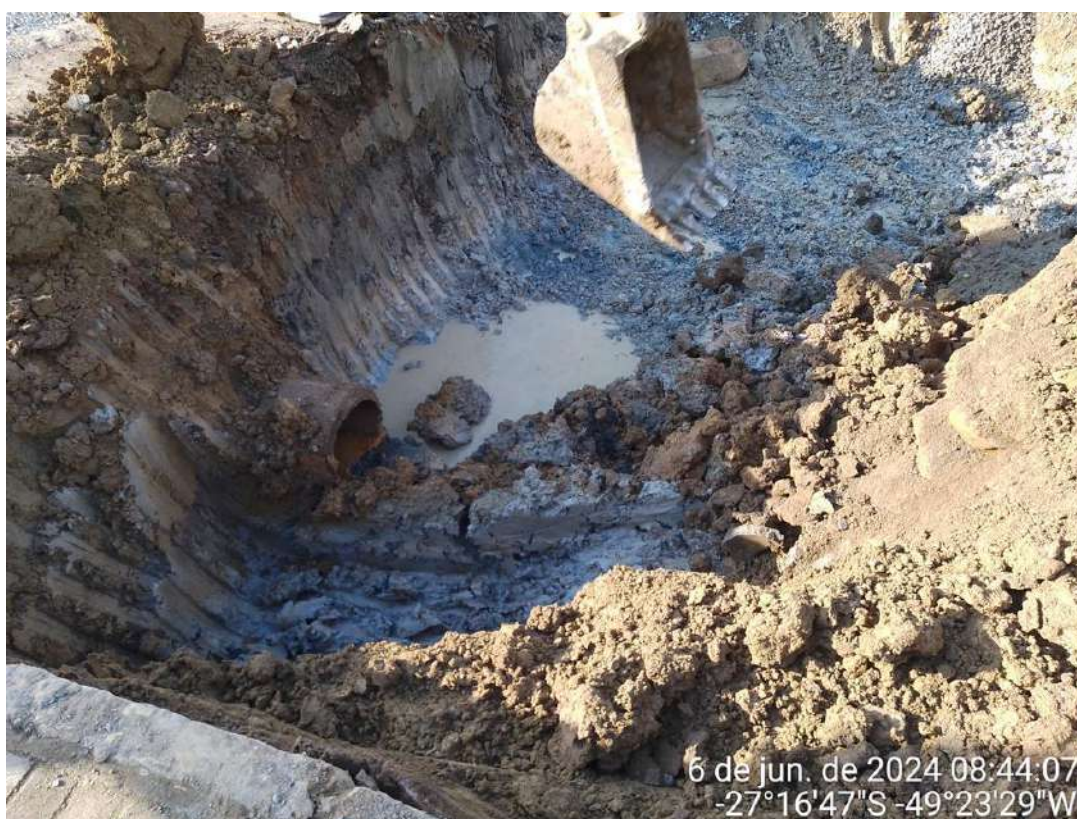
Imagem 11 e imagem 12: Escavação horizontal na região de intervenção apontada no parecer de aditivo.
