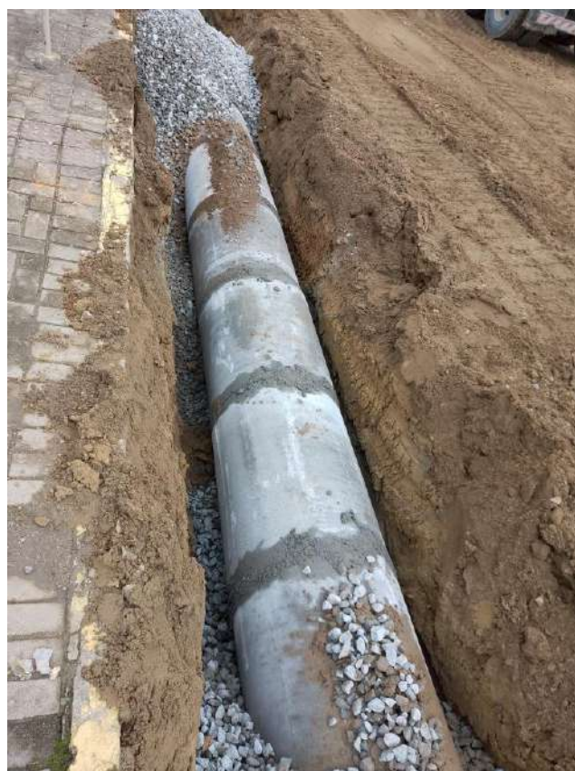
Imagem 03 e Imagem 04: Tubo de concreto, Assentamento de tubo, Camada de brita, Reaterro das valas com brita.
