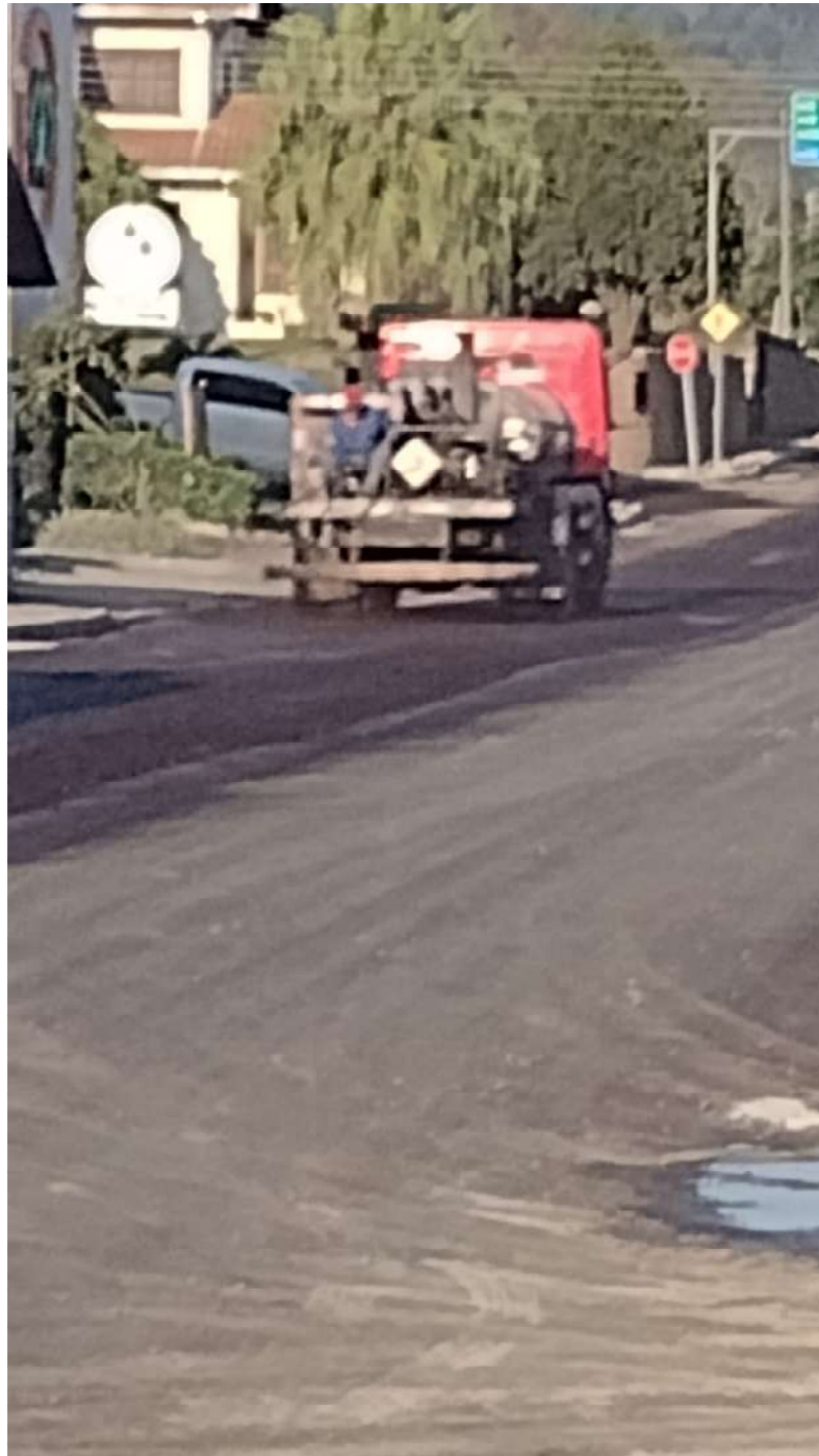
Imagem 10 – Aplicação da Pintura de Ligação
