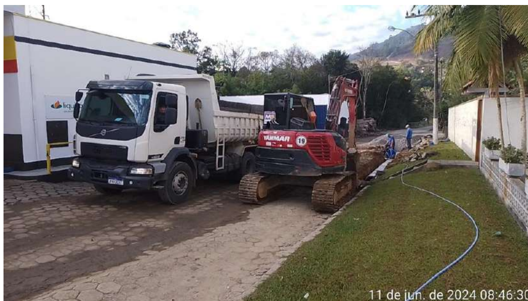
Imagem 30 e imagem 31: Escavação mecanizada de vala com prof. Até 1,5 m, Transporte com caminhão basculante, em via urbana.
