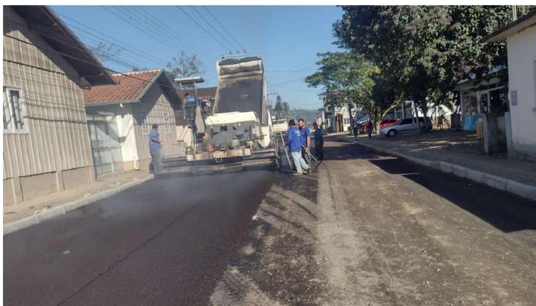
Imagem 09 – Aplicação da Camada Asfáltica
