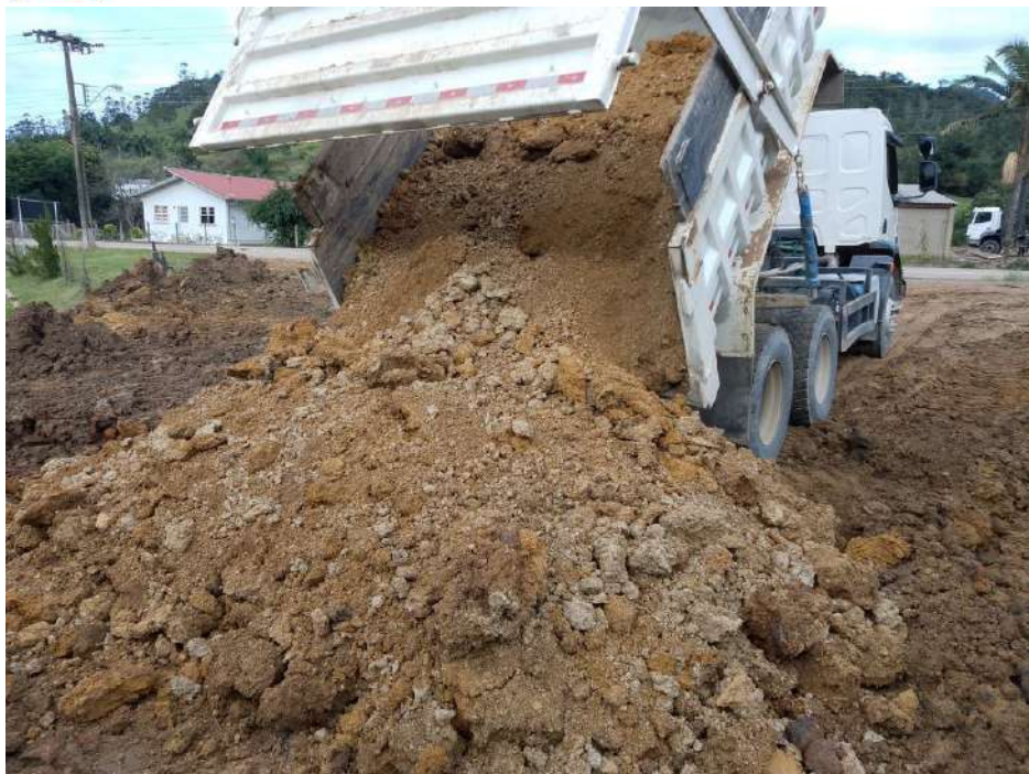
Imagem 08: Transporte com caminhão basculante
