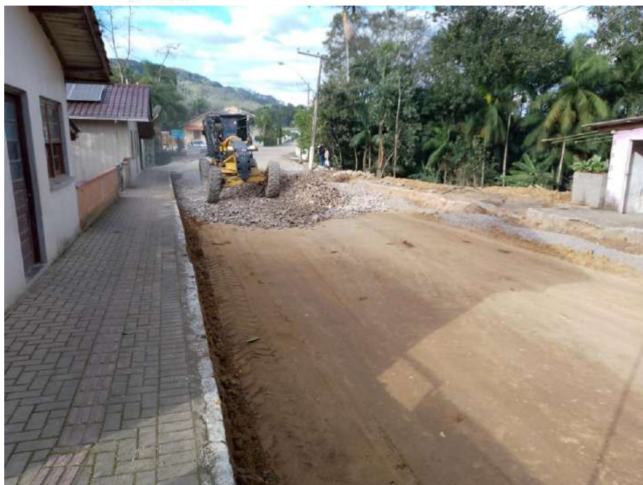
Imagem 18: espalhamento do material macadame seco.
