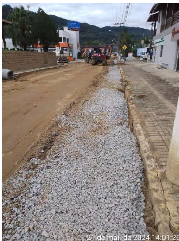
Imagem 28, imagem 29 imagem 30: Camada de brita para assentamento de tubo. Reaterro de valas.
