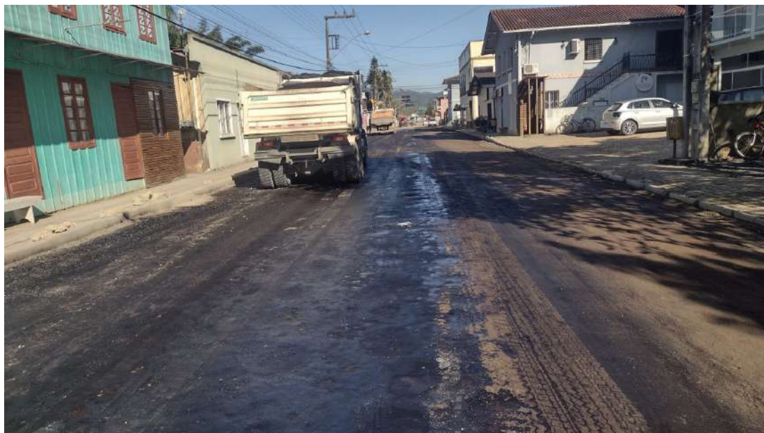
Imagem 05 – Aplicação da Pintura de Ligação
