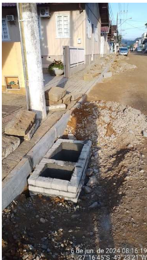
Imagem 94 e imagem 95: Caixa de captação com junção em alvenaria de tijolo maciço e concreto p/ tubos de DN 600mm, incluindo materiais, serviço, escavação e reaterro.
