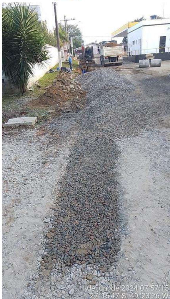
Imagem 34 e imagem 35: Reaterro das valas com brita, fornecimento e colocação.
