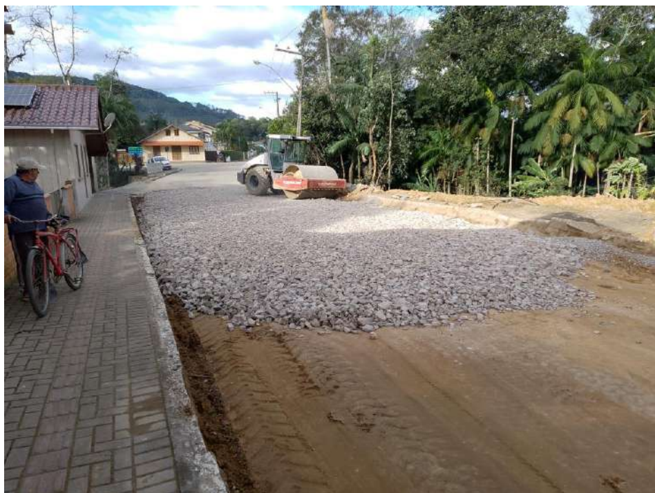
Imagem 20 e imagem 21: Regularização e compactação de subleito de solo predominantemente argiloso. Execução e compactação de base e ou sub base com macadame seco.
