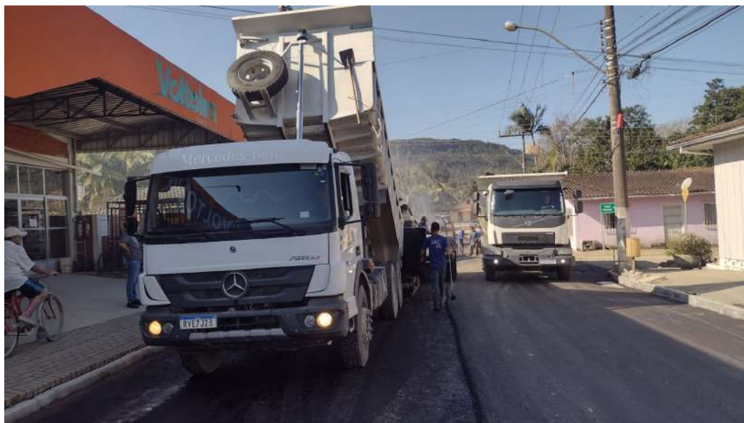
Imagem 02 – Aplicação da Camada asfáltica
