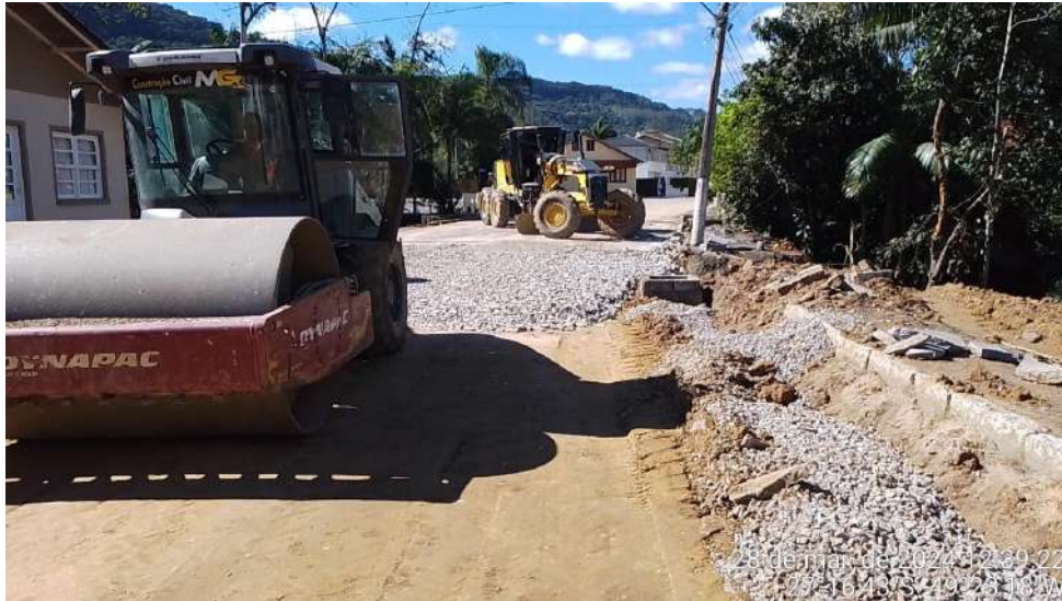
Imagem 51: Regularização e compactação de subleito com uso de motoniveladora, rolo compactador vibratório, incluindo operador. Execução e compactação de base e ou sub base com macadame seco.
