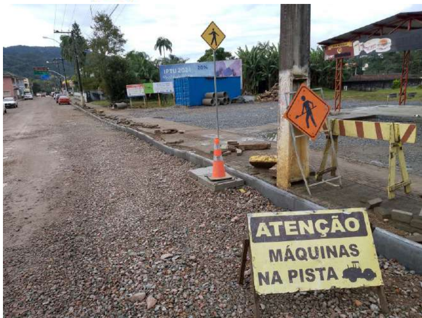
Imagem 24: Sinalizações de obra.
