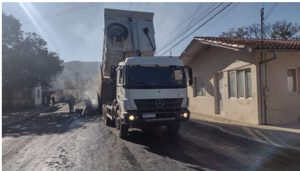
Imagem 06 – Aplicação da Pintura de Ligação
