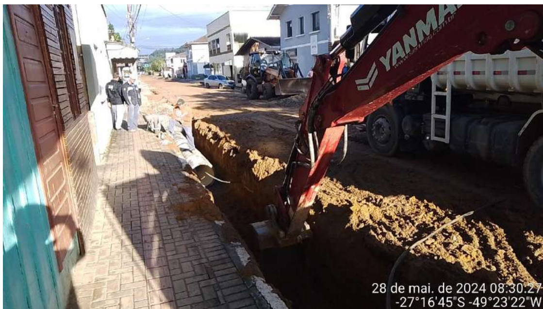
Imagem 50: Tubos de concreto, assentamento de tubos, escavação mecanizada.
