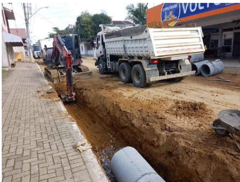
Imagem 06 e Imagem 07: Escavação mecanizada de vala.
