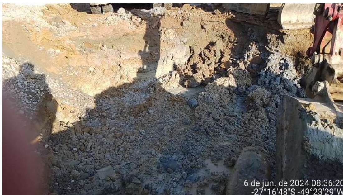
Imagem 13 e imagem 14: Escavação horizontal, incluindo carga e descarga com trator de esteiras.
