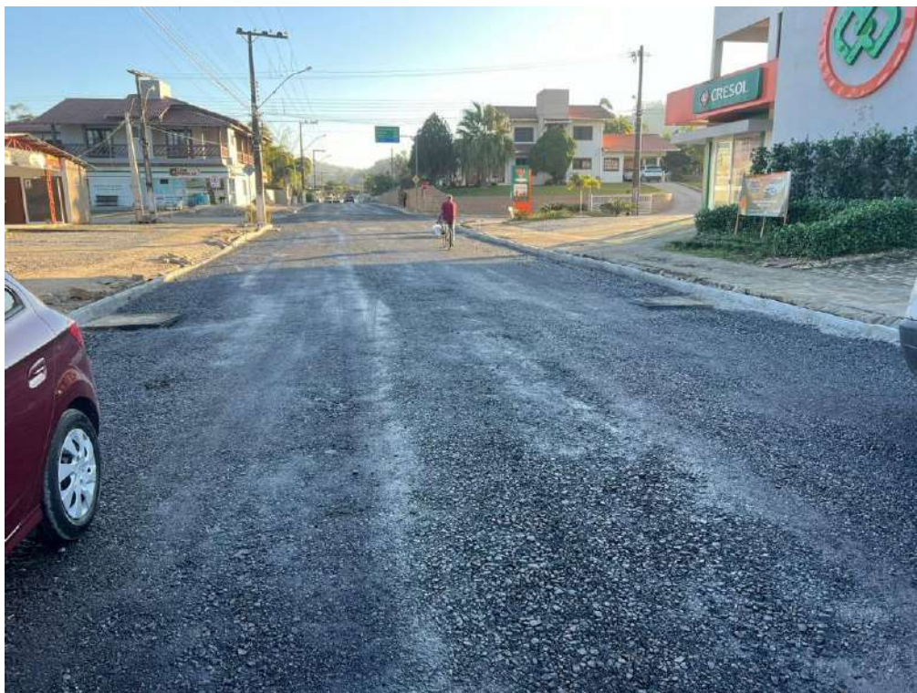
Imagem 04: Execução de pintura de ligação com emulsão asfáltica rr-2c.
