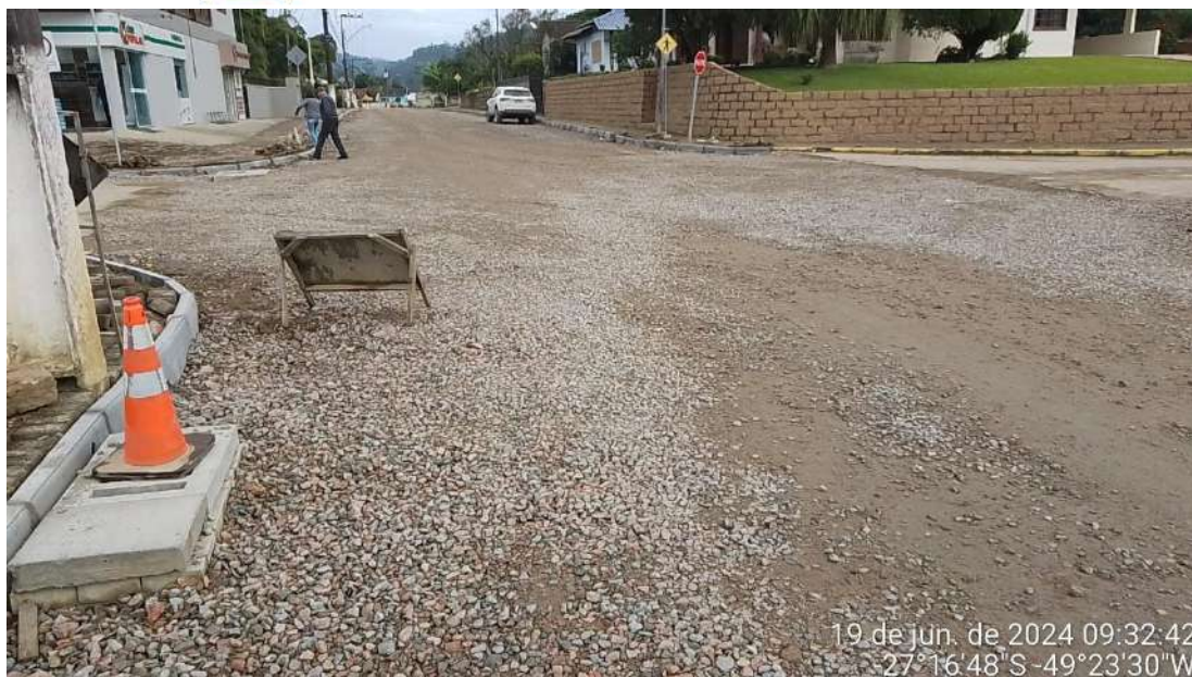
Imagem 108: camada de brita graduada compactada. Caixa de captação executada.
