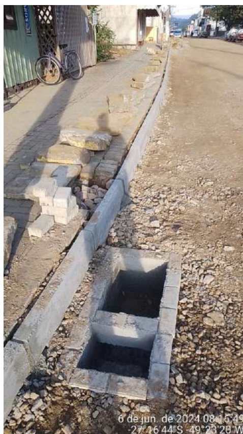
Imagem 94 e imagem 95: Caixa de captação com junção em alvenaria de tijolo maciço e concreto p/ tubos de DN 600mm, incluindo materiais, serviço, escavação e reaterro.
