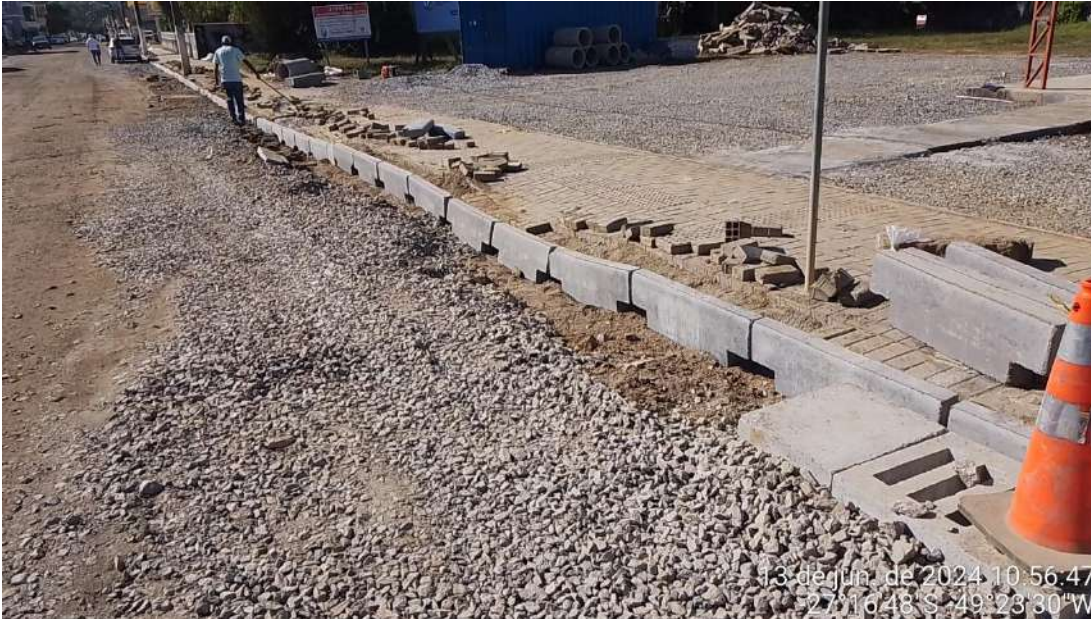
Imagem 104: Colocação de meios-fios Pré moldado de concreto. Caixa de captação executada.
