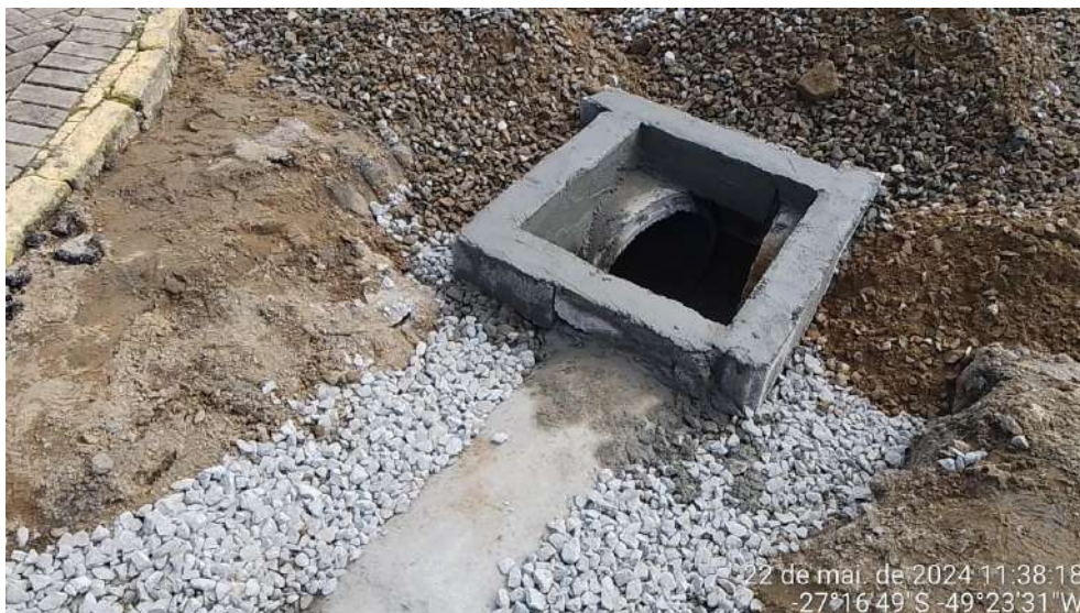
Imagem 33 e imagem 34: Execução de caixa de inspeção e junção.
