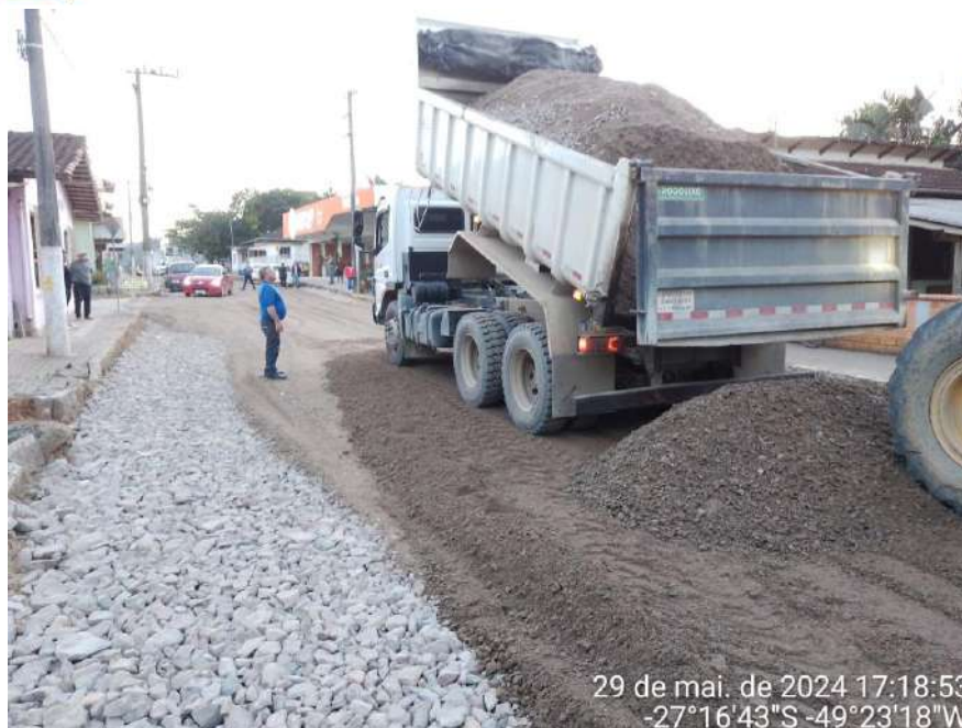
Imagem 74: Execução de base e ou sub base com brita graduada simples sobre a camada de macadame. Transporte de material.
