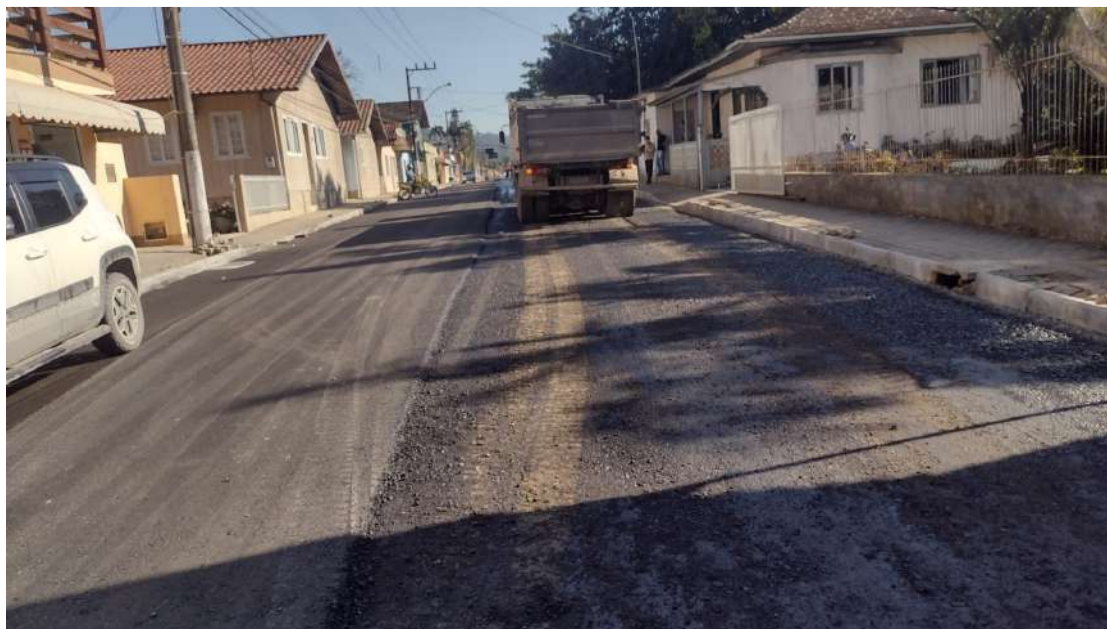
Imagem 01 – Camada asfáltica + Pintura de ligação
