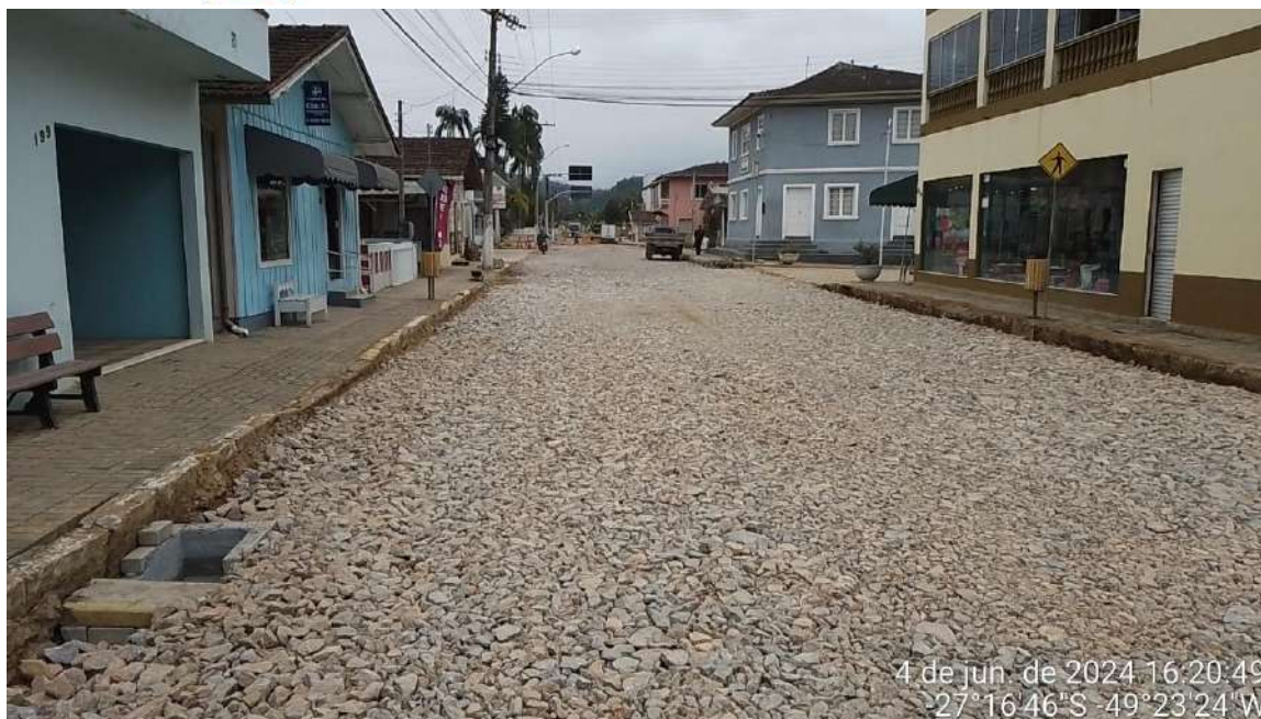
Imagem 86: Execução e compactação de base e ou sub base com macadame seco
