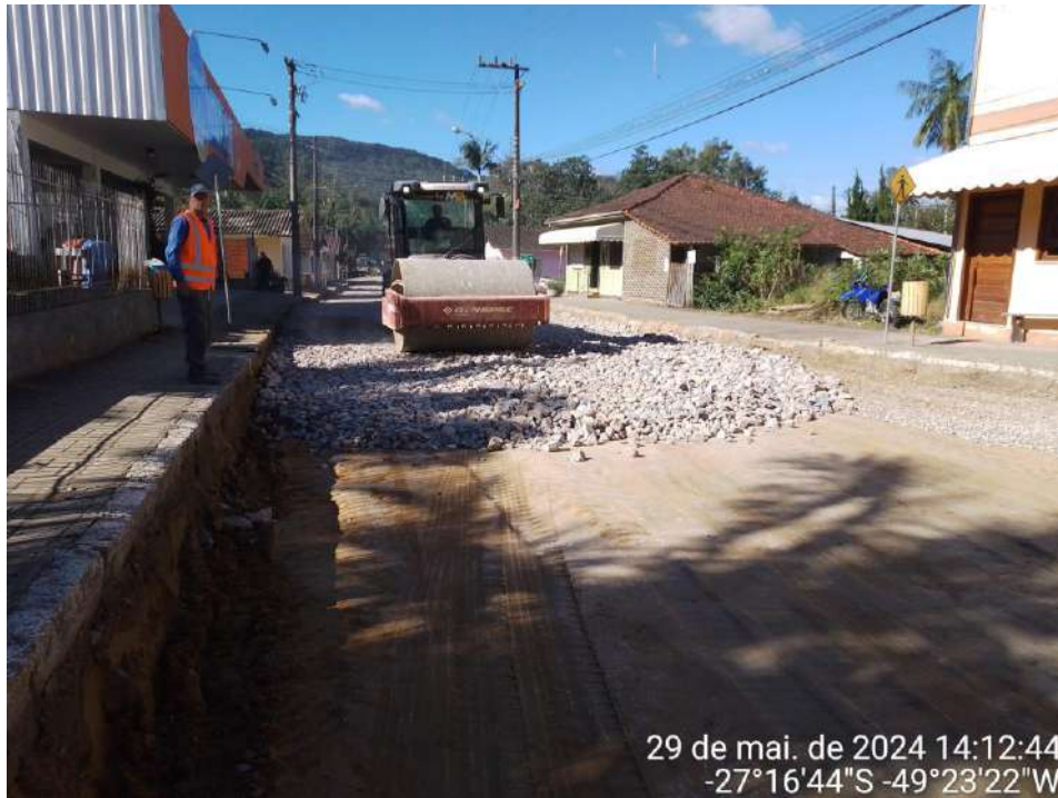
Imagem 68 Regularização e compactação de subleito de solo predominantemente argiloso. Execução e compactação de base e ou sub base com macadame seco.
