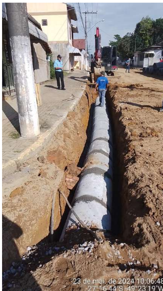
Imagem 42 e imagem 43: Tubos de concreto, vala escavada, junta de argamassa.
