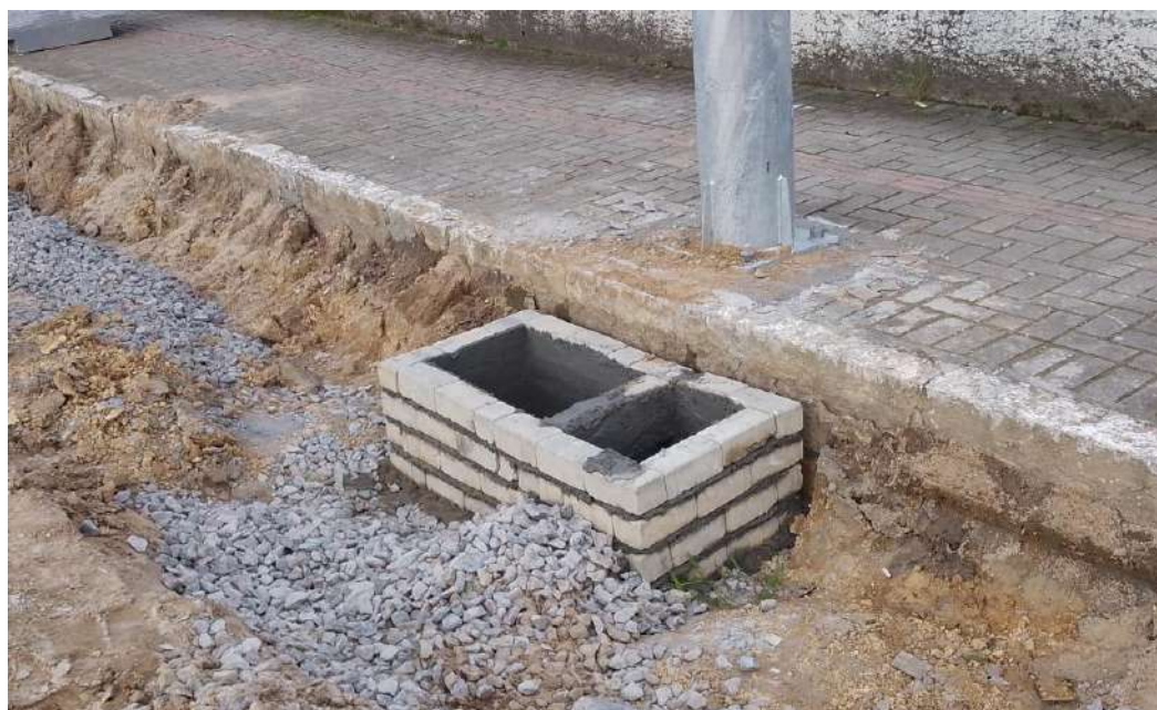
Imagem 62 e imagem 63: Execução de caixa de captação com junção em alvenaria de tijolo maciço e concreto.
