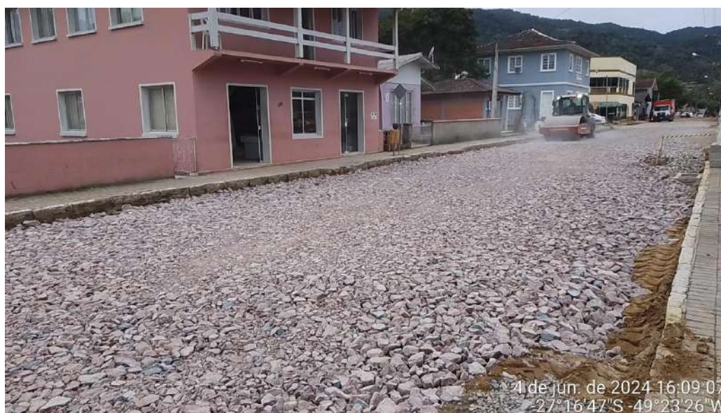
Imagem 81: Execução e compactação de base e ou sub base com macadame seco.
