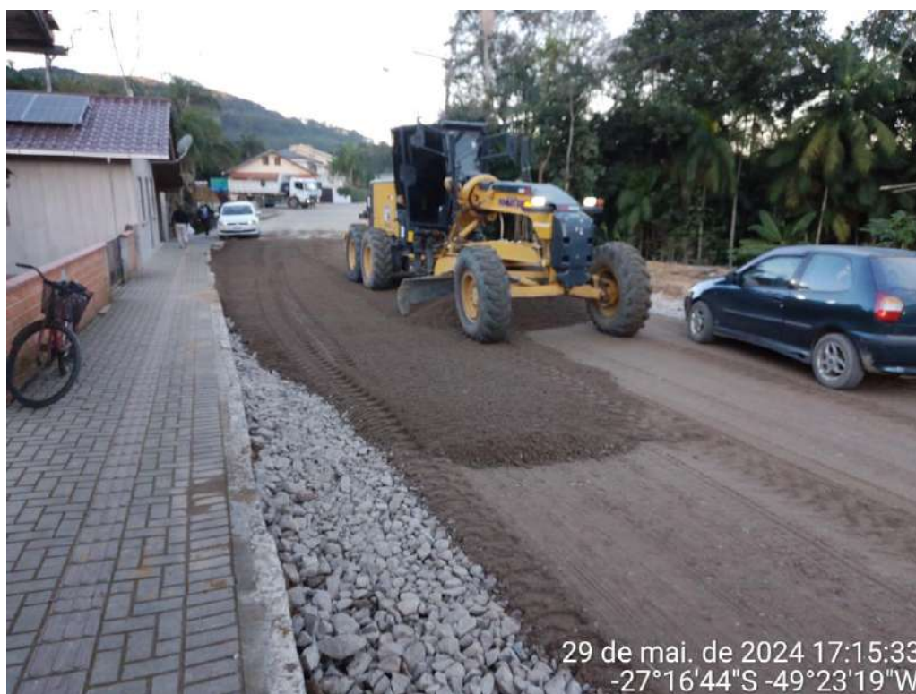
Imagem 70 e imagem 71: execução e compactação de base e ou sub base com brita graduada simples sobre a camada de macadame.
