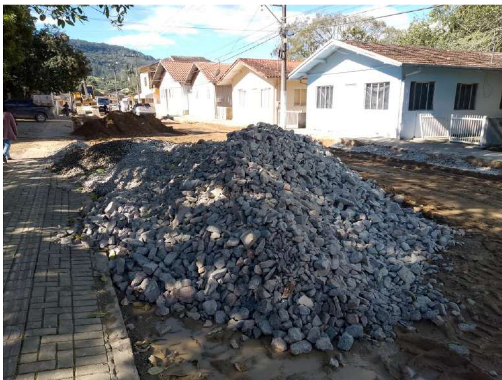
Imagem 13: Material para base da pavimentação.
