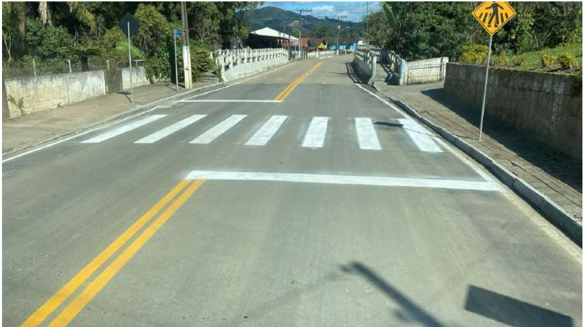
Imagem 12 – Execução do sistema de Sinalização Viária – Horizontal e Vertical
