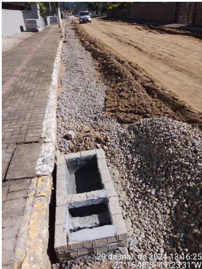
Imagem 64 e imagem 65: Execução de caixa de captação com junção em alvenaria de tijolo maciço e concreto.
