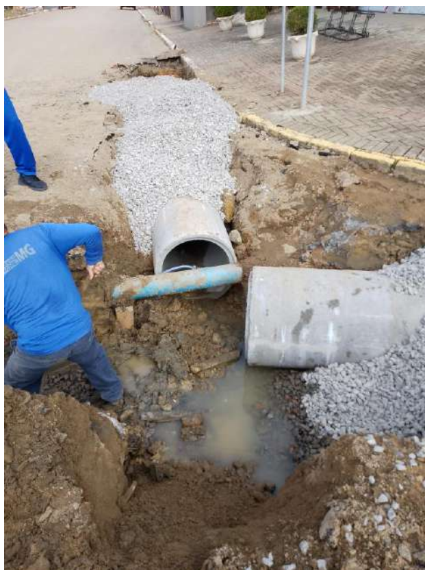
Imagem 09 e Imagem 10: Tubo de concreto, Assentamento de tubo, Camada de brita, Reaterro das valas com brita.
