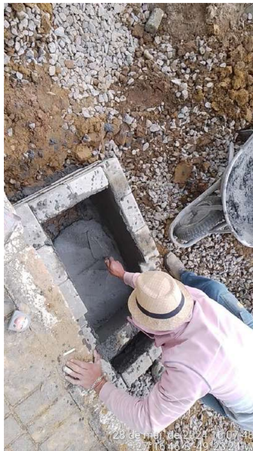
Imagem 64 e imagem 65: Execução de caixa de captação com junção em alvenaria de tijolo maciço e concreto.
