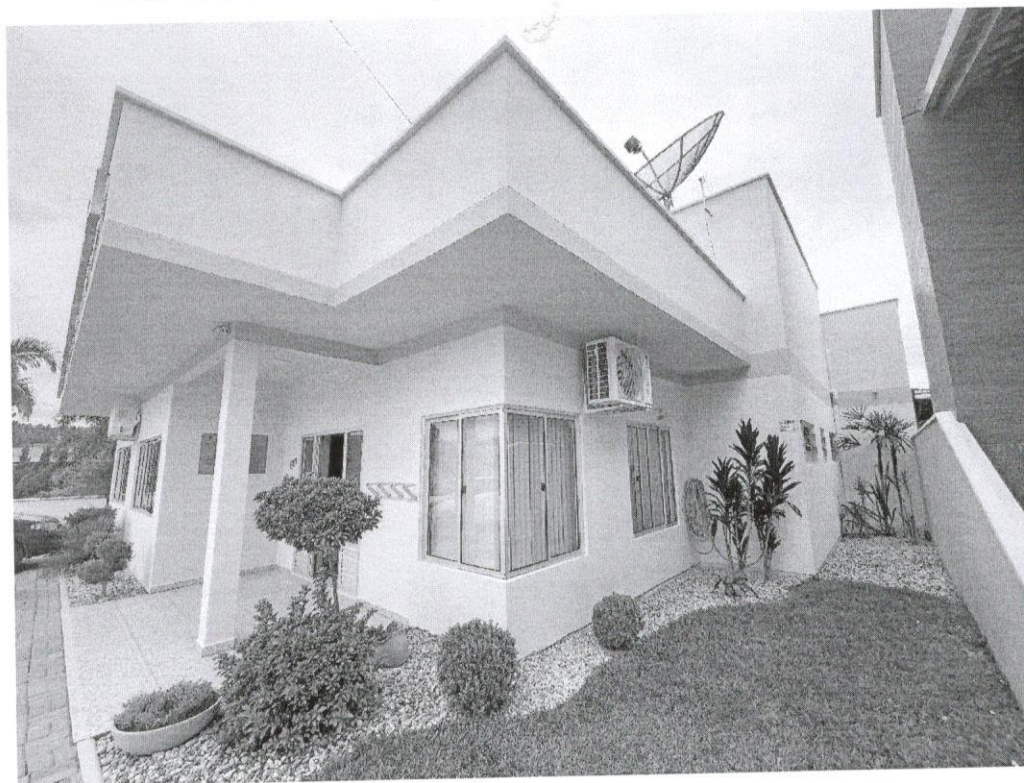
Fotos 49 a 57 – Revitalização das Paredes externas da edificação
